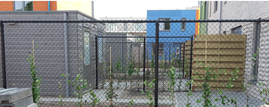
uitvoering van de erfafscheiding in fase 01, in fase 02 wordt hetzelfde systeem toegepast
