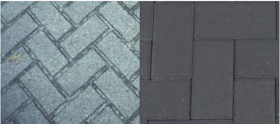
verharding parkeerstraat, betonstraatstenen grijs verharding parkeervak, betonstraatstenen antraciet
