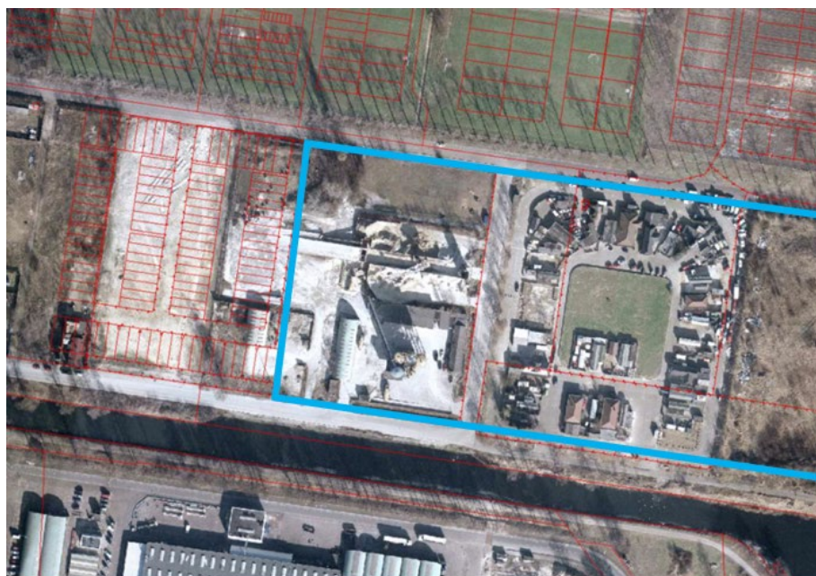
Figuur 3-5 Luchtfoto betonmortelcentrale (en naastgelegen woonwagenkamp) uit 2003 (grenzen plangebied in blauw)
