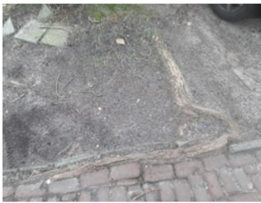
Boom 16 met wortelschade en opdruk
