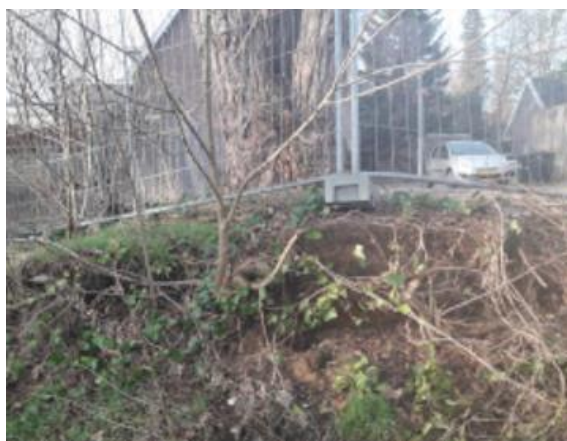
Boom 15 met wortelschade door graafwerk
