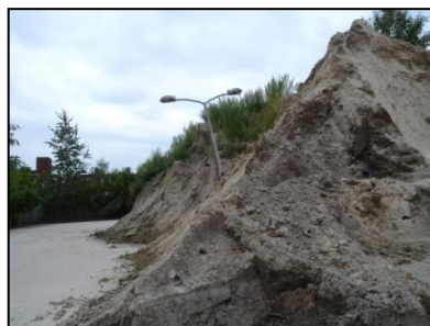
Figuur 7. Zanddepot op parkeerplaats.
