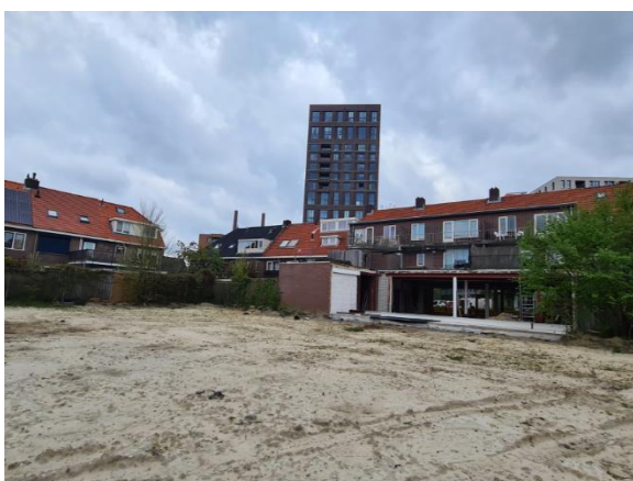
Figuur 7. Noordoosthoek plangebied met werkzaamheden
