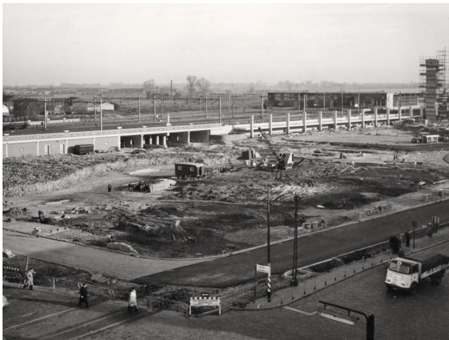
Afbeelding 2.2: Werkzaamheden aan het Stationsplein en het 18-Septemberplein (jaar 1955)
