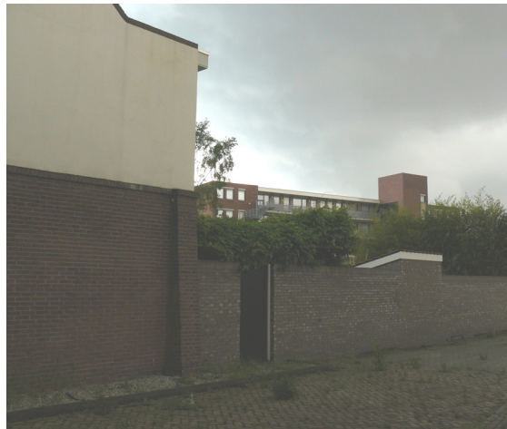
Afb. 8 Bergstraat 24 noordwest gevel.
