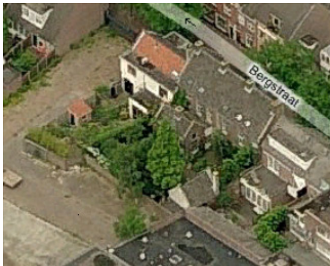
Afb. 6 Luchtfoto van de achterzijde pand Bergstraat 26-30.
