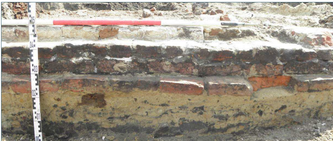
Afbeelding 6 Representatieve afbeelding van de fundering van het muurwerk binnen het Luciferterrein. Op de foto is het muurwerk van S204 te zien. Bron: Foto Vestigia, d.d. 8-6-2016
