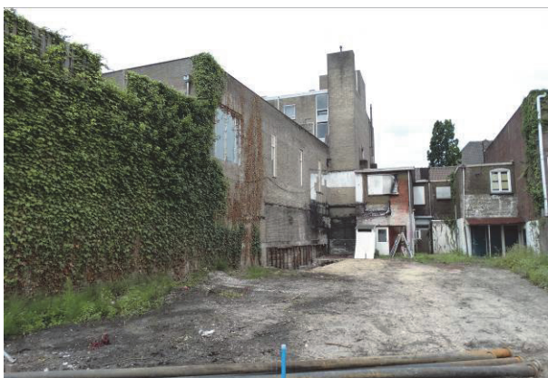
Figuur 5: Aanzicht achterzijde plangebied met begroeiing van klimop aan de muren
