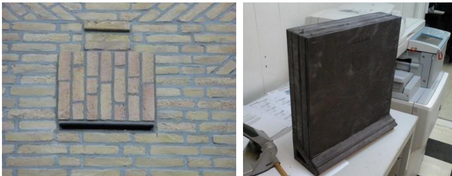
Figuur 3: Permanente voorziening vleermuizen, inmetsele kast type Tichelaar.
