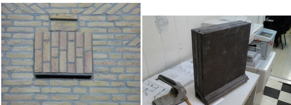
Afbeelding 2: Voorbeeld mitigatie vleermuizen, links; vleermuiskast vivara, rechts; inmetselfkast vivara, onder inbouw type Tichelaar.
