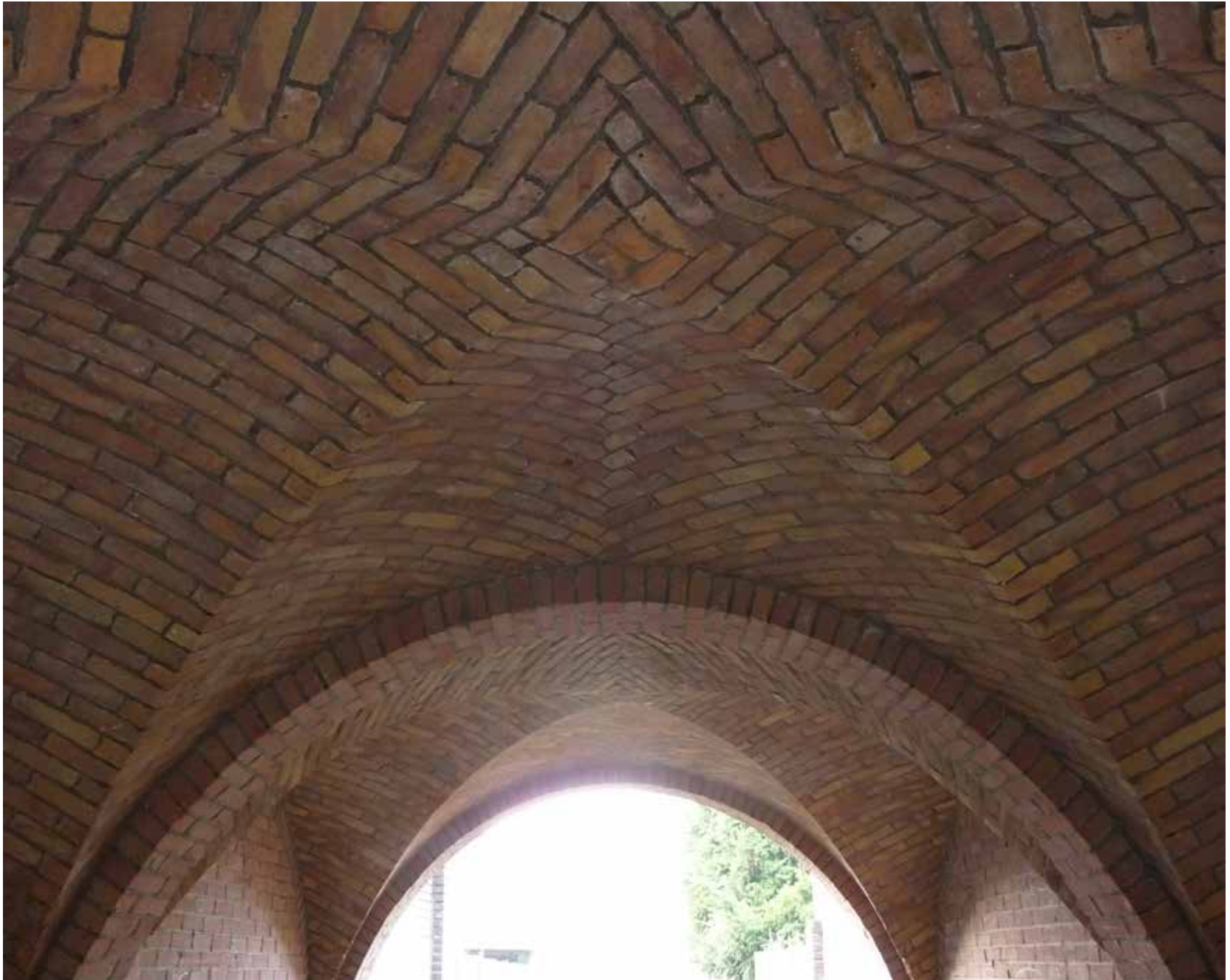
Gemetselde graatgewelven in de onderdoorgang van de poort aan de Neushoornstraat.
