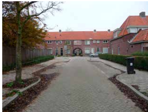
Zicht vanuit de kop van de Poemastraat op de onderdoorgang in de Tijgerstraat.
