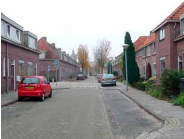
Tijgerstraat ter plaatse van de kruising met de Poemastraat. Rechts de onderdoorgang.
