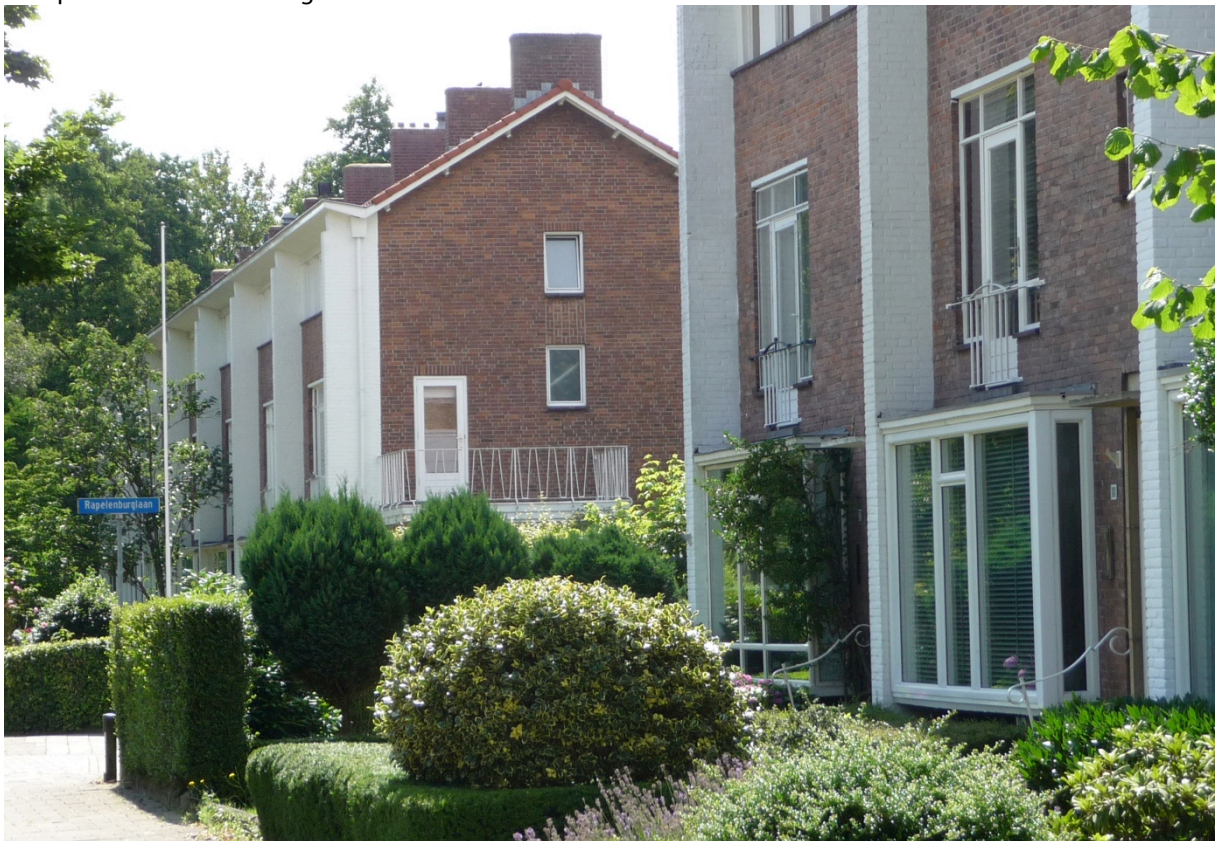
Complexonderdeel 1: voorgevels overhoeks met zicht op de kopgevel.
