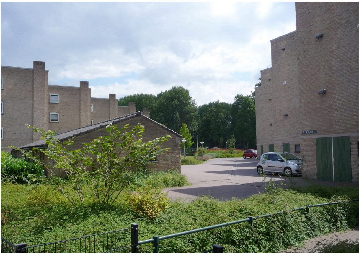
Complexonderdeel 3: zicht tussen de woningen in de richting van het Dommelplantsoen.
