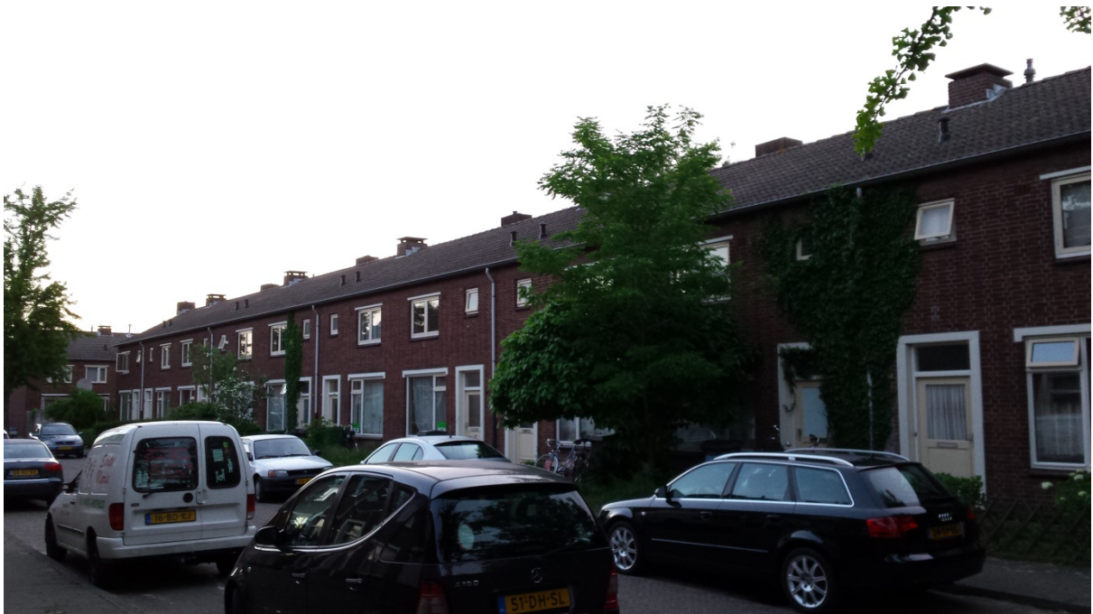
Figuur 2.3: een deel van de te slopen woningen aan de Clematisstraat. Dit type gebouw is zeer in trek bij de huismus.
