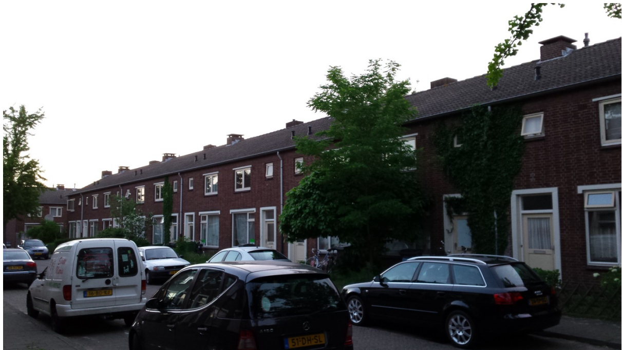
Figuur 3: een deel van de te slopen woningen.
