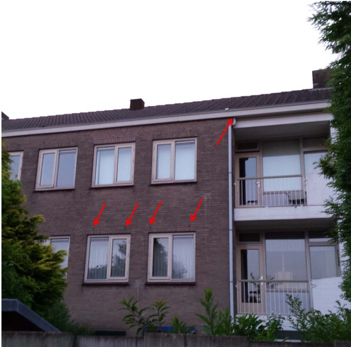
Figuur 5: spouwmuurventilatie en regenpijpen bieden vaak toegang voor een gebouwbewonende soort als de gewone dwergvleermuis, evenals een stenen pannendak. Onderliggende tuinen maken vaak deel uit van het jachtgebied van vleermuizen.
