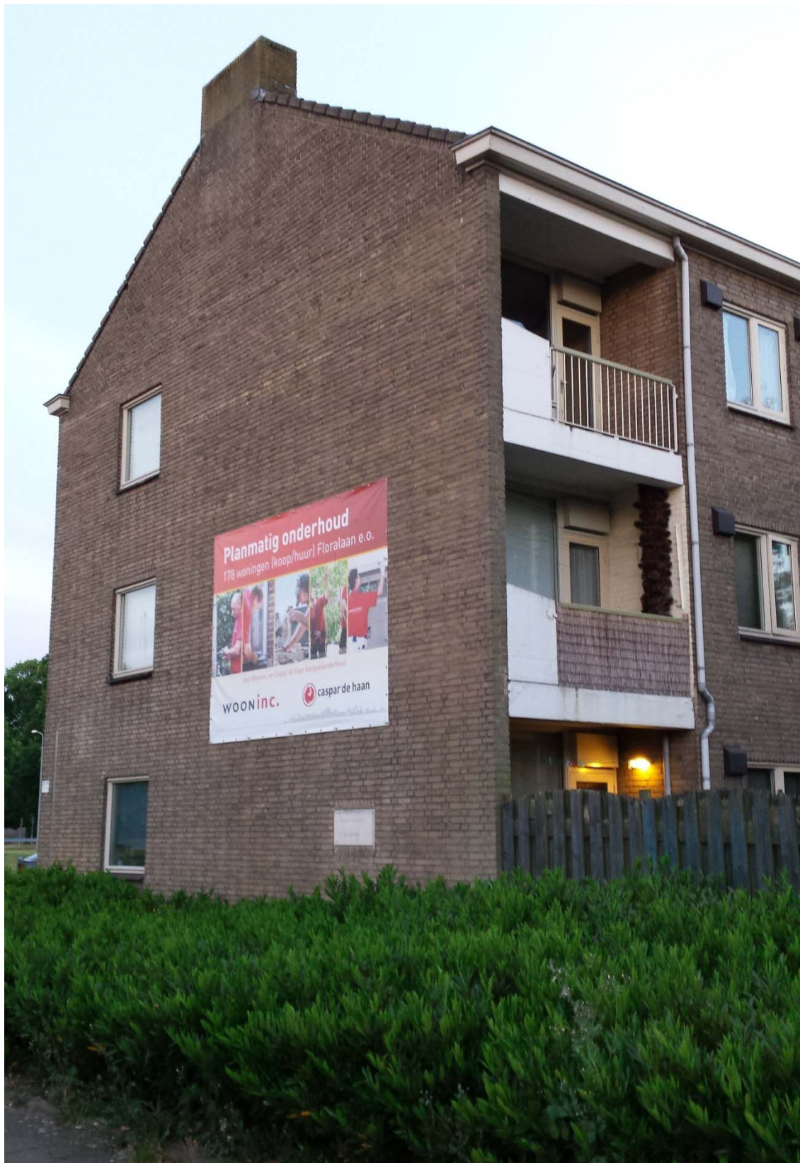
Figuur 4: zij aanzicht van een van de te slopen gebouwen aan het Floraplein.
