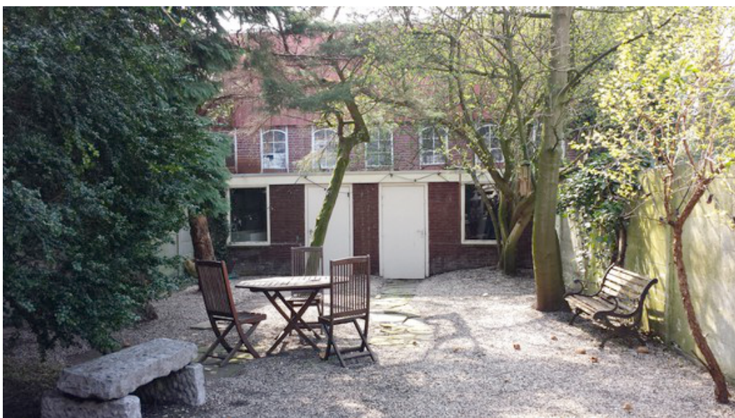
Aangebouwde kantoorruimte aan de oostzijde van de loods
