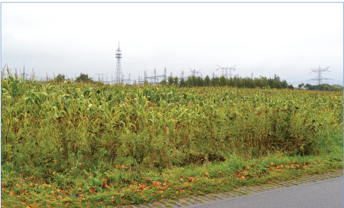
Figuur 5. Achter de mais doemt het trafostation op (foto: Luuk Keunen, 6 oktober 2015).
