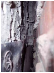
Open spouw (dichtgezet bij kelderraam)
