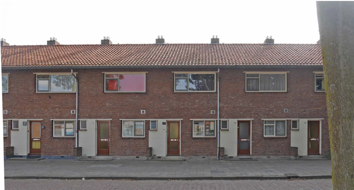
bestaande situatie type c foto
