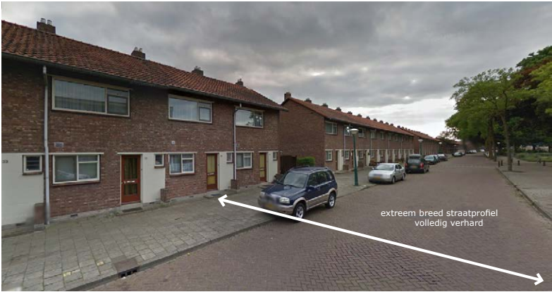
openbare ruimte struyckenstraat bestaande situatie type c | foto
