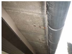
Goten met lichte oxidatie plekken
