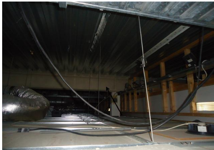
Spuitlaag tegen balkconstructie
