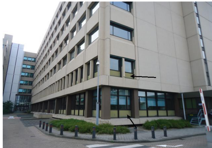
Sandwichpanelen in de kozijnconstructie.
