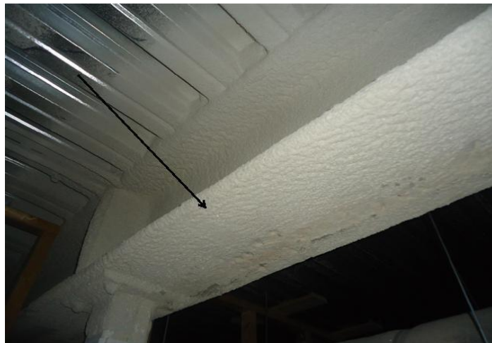
Spuitlaag tegen balkconstructie
