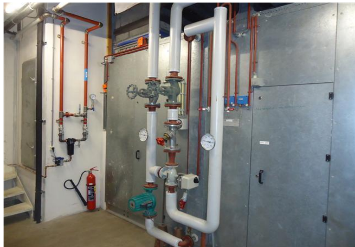
Pakkingen in de technische ruimte
