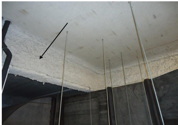
Spuitlaag tegen de balkconstructie.
