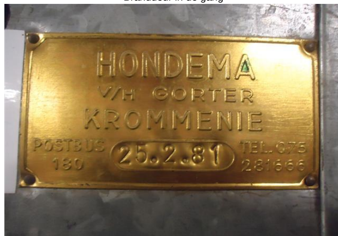
Label branddeur in souterrain
