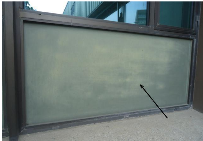
Sandwichpanelen in de kozijnconstructie.
