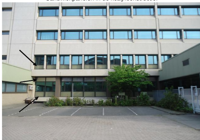
Sandwichpanelen in de kozijnconstructie.
