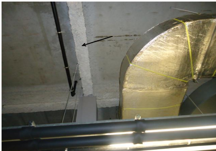
Spuitlaag tegen de balkconstructie.
