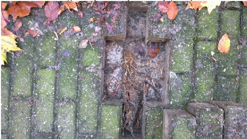
Foto 8. Beeld van oppervlakkige beworteling en verhardingsopdruk bij boom 26
