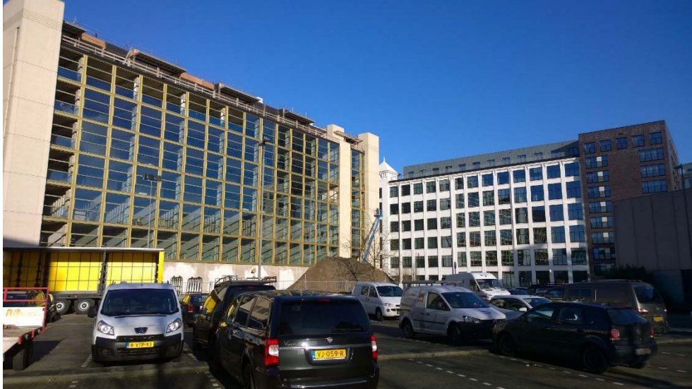
Foto 1. verbouwing van aanwezige bebouwing
