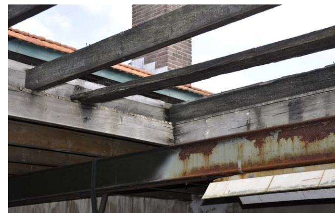
stalen liggers en restanten daklichtconstructie
