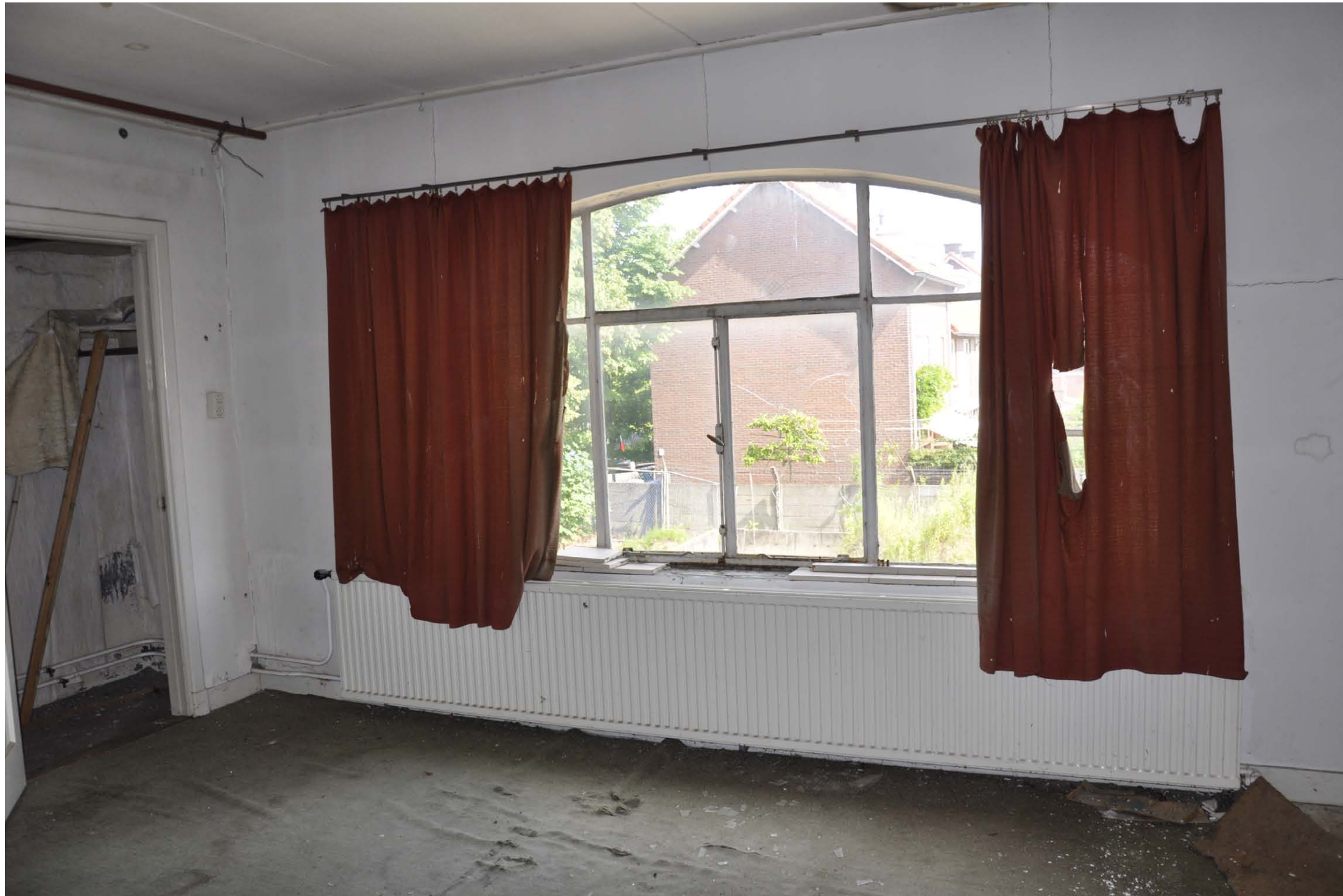
voormalige woonkamer woonhuis
