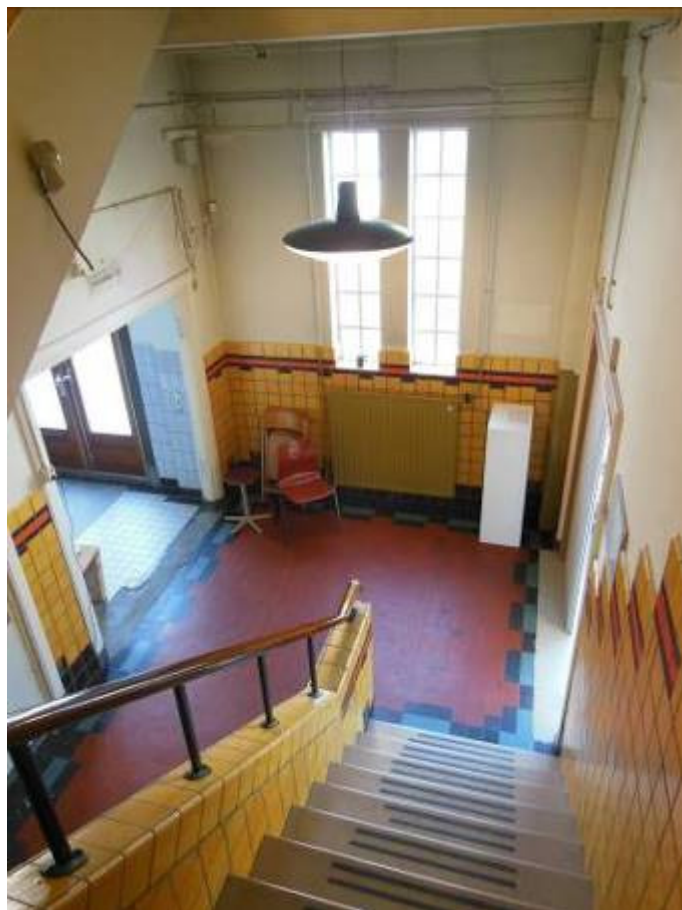
trappenhuis begane grond toonzaalvleugel met originele plavuizen en betegeling
