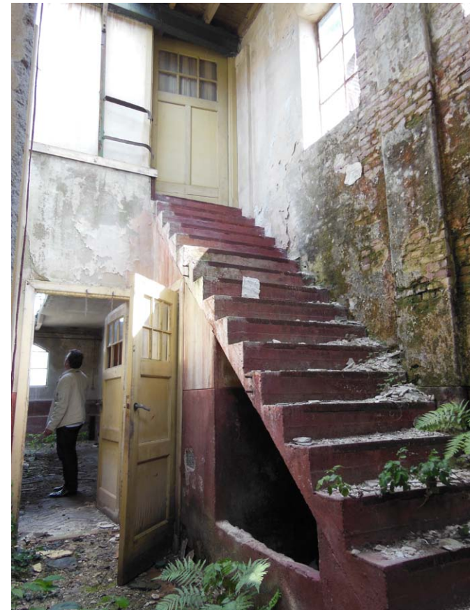
trap in locomobielruimte
