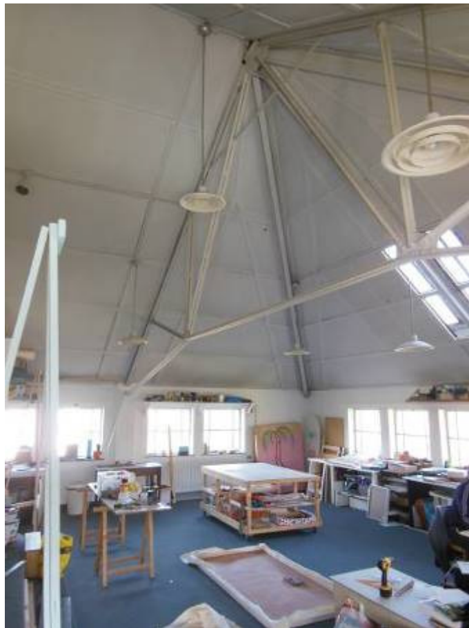
ruimte op eerste verdieping van de toonzaalvleugel met Polonceauspant
