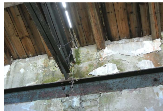
aansluiting spant op wand
