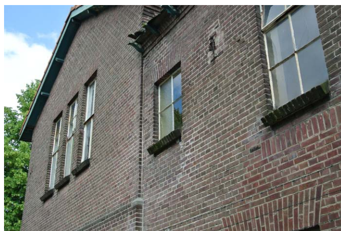
detail noordwest gevel
