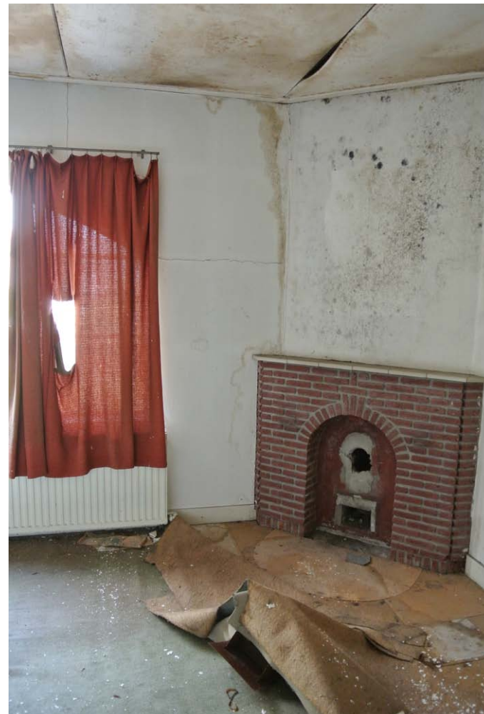
voormalige woonkamer woonhuis
