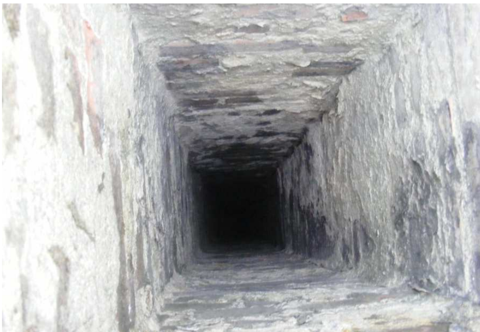
Foto 2. Kanaal van de schoorsteen.
