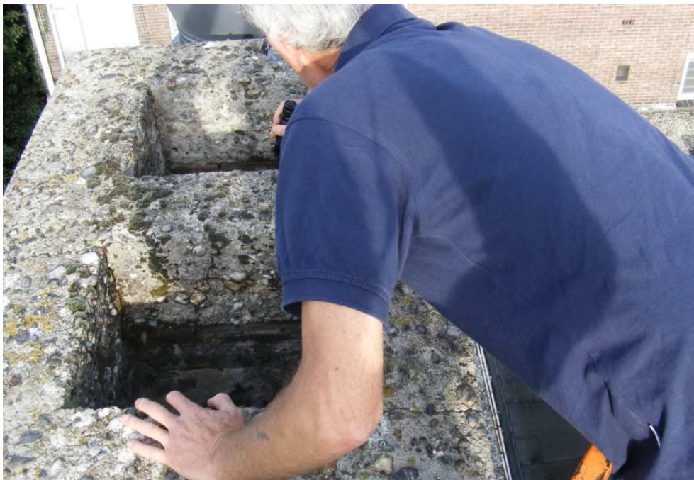
Foto 1 inspectie schoorsteen vanuit hoogwerker.
