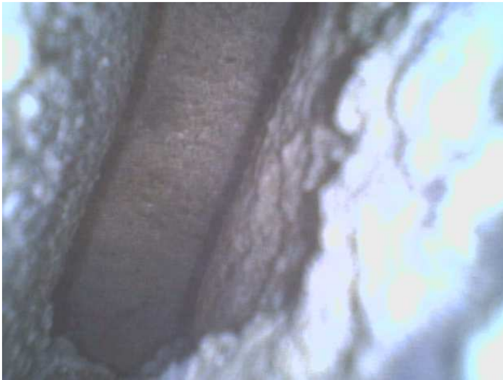
Foto 3. Inspectie middels een kierenkijker van de spouwmuurachtige ruimte in de schoorsteen.
