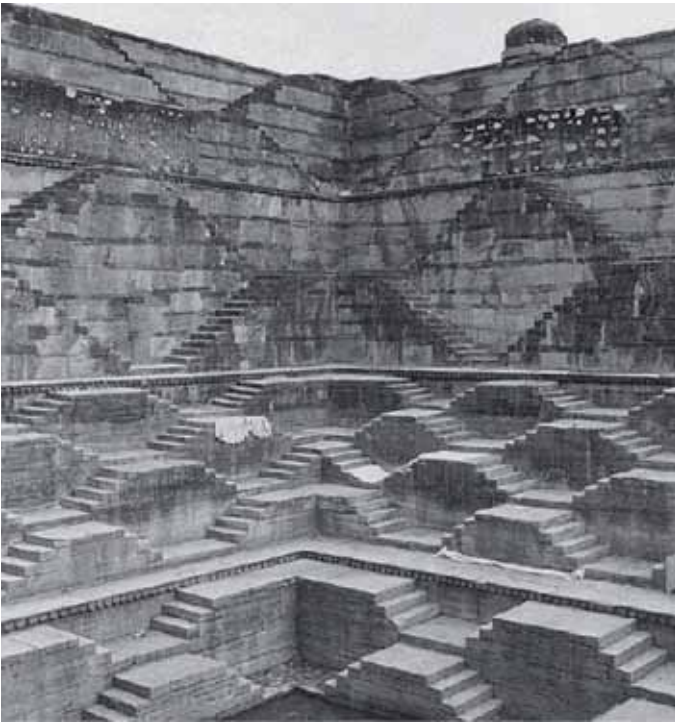
Het waterplein biedt ruimte aan klimmend grondwater
