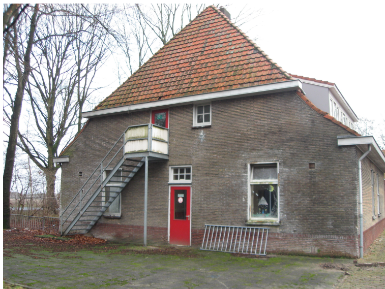
Foto 1: te slopen bebouwing
