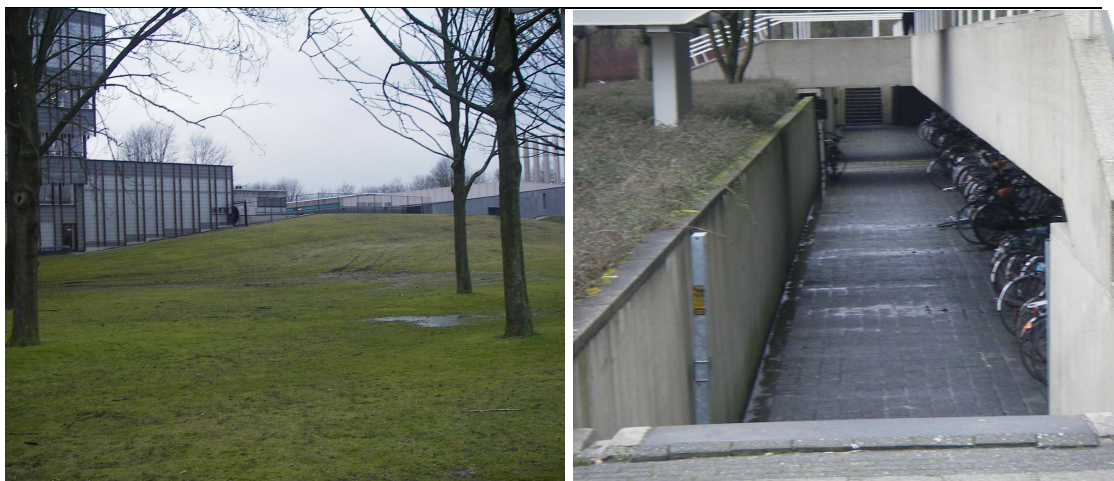
Figuur 2.4 Foto water op gras (bij gebouw Cascade) en water in fietsenstalling (bij gebouw Auditorium)
