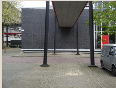
Aansluiting portalen loopbrug op het maaiveld
