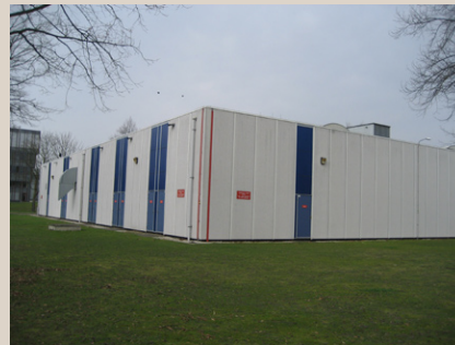
5 Berging bijzondere chemicaliën (BBC) Sloop en nieuwbouw op zelfde locatie Ontwerp: TEBODIN Bouwjaar: 1994
