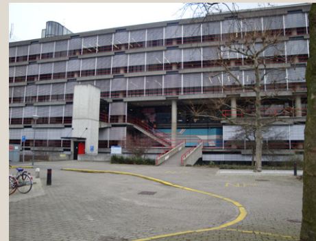
Entree en gevel W-hoog
