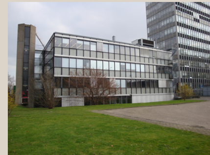
9 Corona Oorspronkelijk: Uitbreiding Elektrotechniek Ontwerp: S.J. van Embden Bouwperiode: oktober 1969 - april 1972
