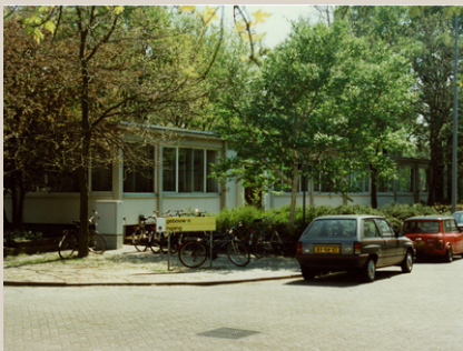
7 Gebouw O Gesloopt 2006 Oorspronkelijk: Gebouw voor Bedrijfskunde Ontwerp: S.J. van Embden Bouwperiode: december 1969 - juni 1972
