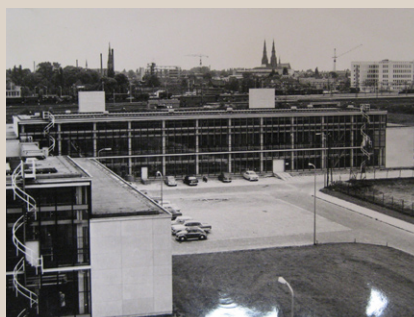
8 De Hal Oorspronkelijk: CT-hal, hal Chemische Technologie Ontwerp: S.J. van Embden Bouwperiode: februari 1958 - mei 1959
