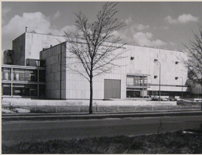
1 Gebouw Warmte en Strooming Gesloopt Ontwerp: S.J. van Embden Bouwperiode: december 1965 - maart 1968
