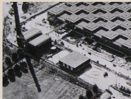
14 Trafo- en ontvangststation
