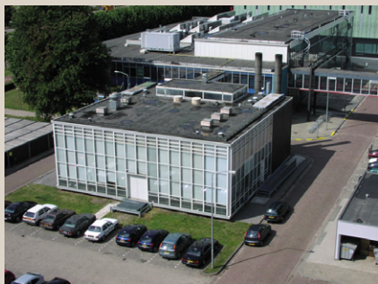
16 Gaslab Renovatie en herbestemming tot (muziek)theater Ontwerp: J. Swagten Bouwjaar: 2002
