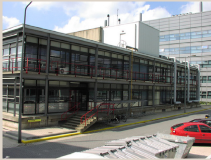
10 Reactor Athene Oorspronkelijk: Atoomkernreactor TH Eindhoven Ontwerp: S.J. van Embden Bouwperiode: mei 1966 - juni 1967
