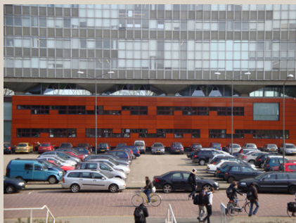
10 Hoofdgebouw Renovatie en uitbreiding begane grond Ontwerp: Kuiper Compagnons Bouwperiode: 1998 - 2000
