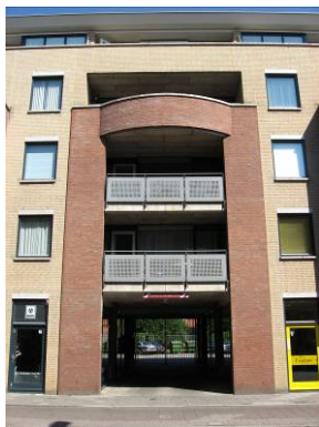
Afb. 134 Grote Berg, onderdoorgang naar de Rungraaf. Op deze wijze wordt de geslotenheid van de gevelwand behouden.
