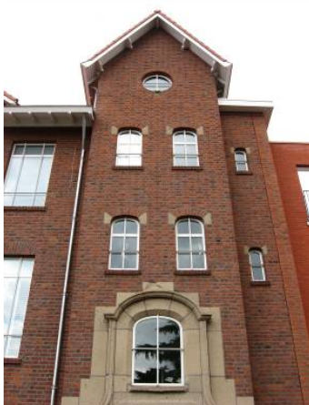
Afb. 121 Anna van Egmondstraat 10-14, de voormalige textielschool. Het gebruik van zandsteen rondom de entreepartij en bij de aanzetstukken van de vensterbogen, sluit aan bij de esthetica van de architectuur uit de periode 1870-1920.
