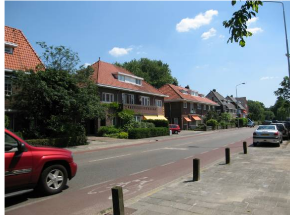
Afb. 107 De woningen langs de Edenstraat behoren tot de weinige reeks panden in De Bergen met voortuinen.
