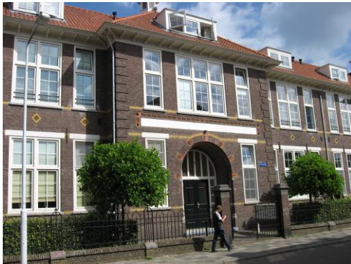
Afb. 111 Julianahof 2-18. Voorbeeld van een grootschalig pand dat vanwege vormgeving en materiaal toch aansluit op de overige bebouwing.
