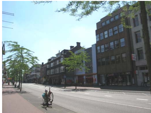
Afb. 132 Keizersgracht anno 2008. De historische scheiding is verdwenen. De huidige boomaanplant draagt door de afstand tussen de bomen weinig bij aan de (historische) beleving van de straat.
