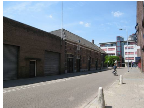
Afb. 72 Paradijslaan. De straat is beklinterd. De stoep is voorzien van betonnen stoep-tegels.
