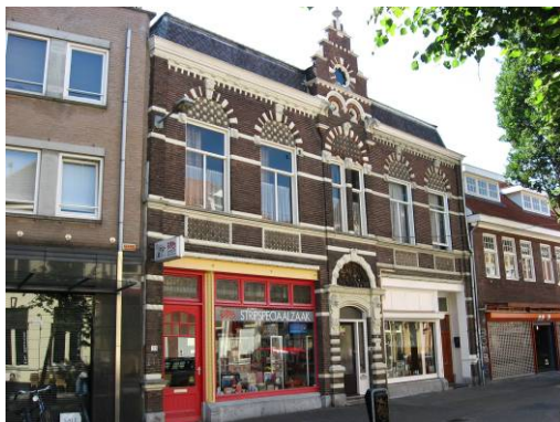
Afb. 117 Kleine Berg 33-37, atelier van de beeldhouwer Van der Marck. Voorbeeld van een voornaam pand, opgetrokken in baksteen met een rijke detaillering van de kroonlijst, deurlijsting, boogvelden gevelbekroning en speklagen.
