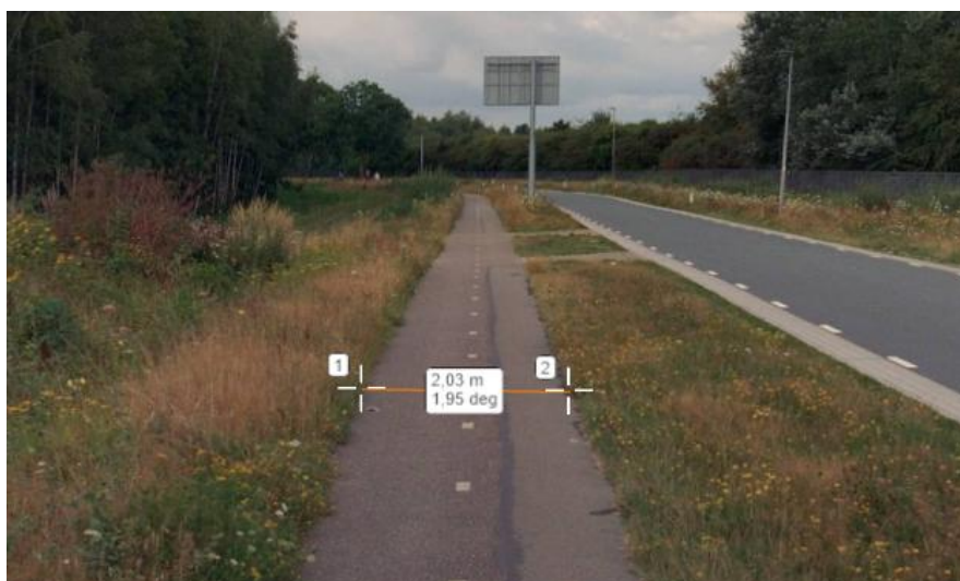
Figuur 3-5: Fietspad Landsardseweg
