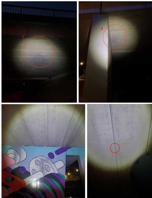
Figuur 3.3. Locaties waar verblijfplaatsen zijn geconstateerd in de brug. Bron: Psecologie.
