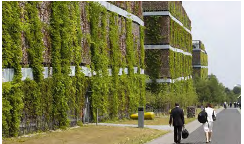
Zorgvuldig ontworpen gevel met begroeiing in de hoofdrol
