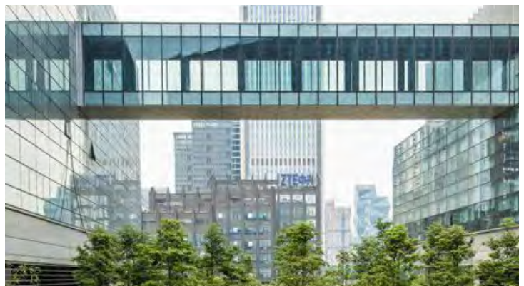
Architectuur brug oogt licht en sluit aan bij de gebouwen die het verbindt.
