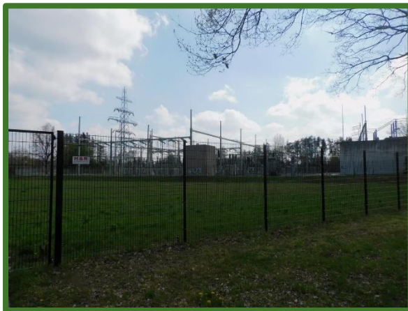
Overzicht omheining noordzijde plangebied
