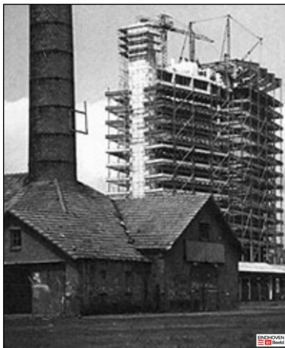
Figuur 6. De steenfabriek van Van Hapert en het destijds nieuwe kantoorgebouw van Philips op de achtergrond (1964, Eindhoven in Beeld)
