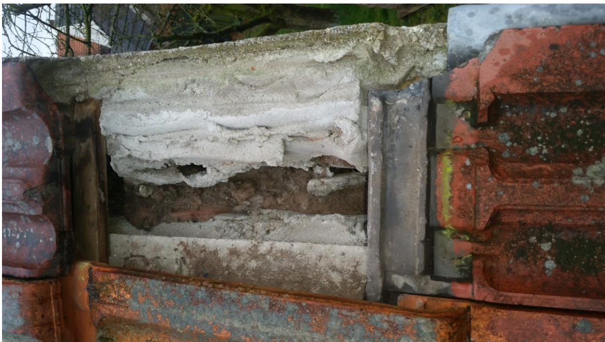
Inspectie onder dakpannen
