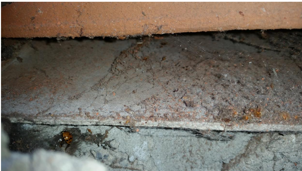
Aanwezige ruimte onder dakpan, gezien van de zijkant van het gebouw.
