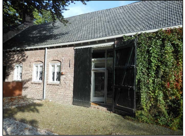
Foto 2. Zuidzijde gebouw (voorbeeld te plaatsen ramen)
