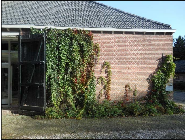
Foto 1. Zuidzijde gebouw (muur waar ramen worden geplaatst)
