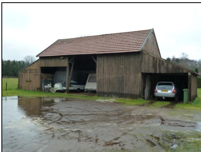
De karakteristieke houten schuur
