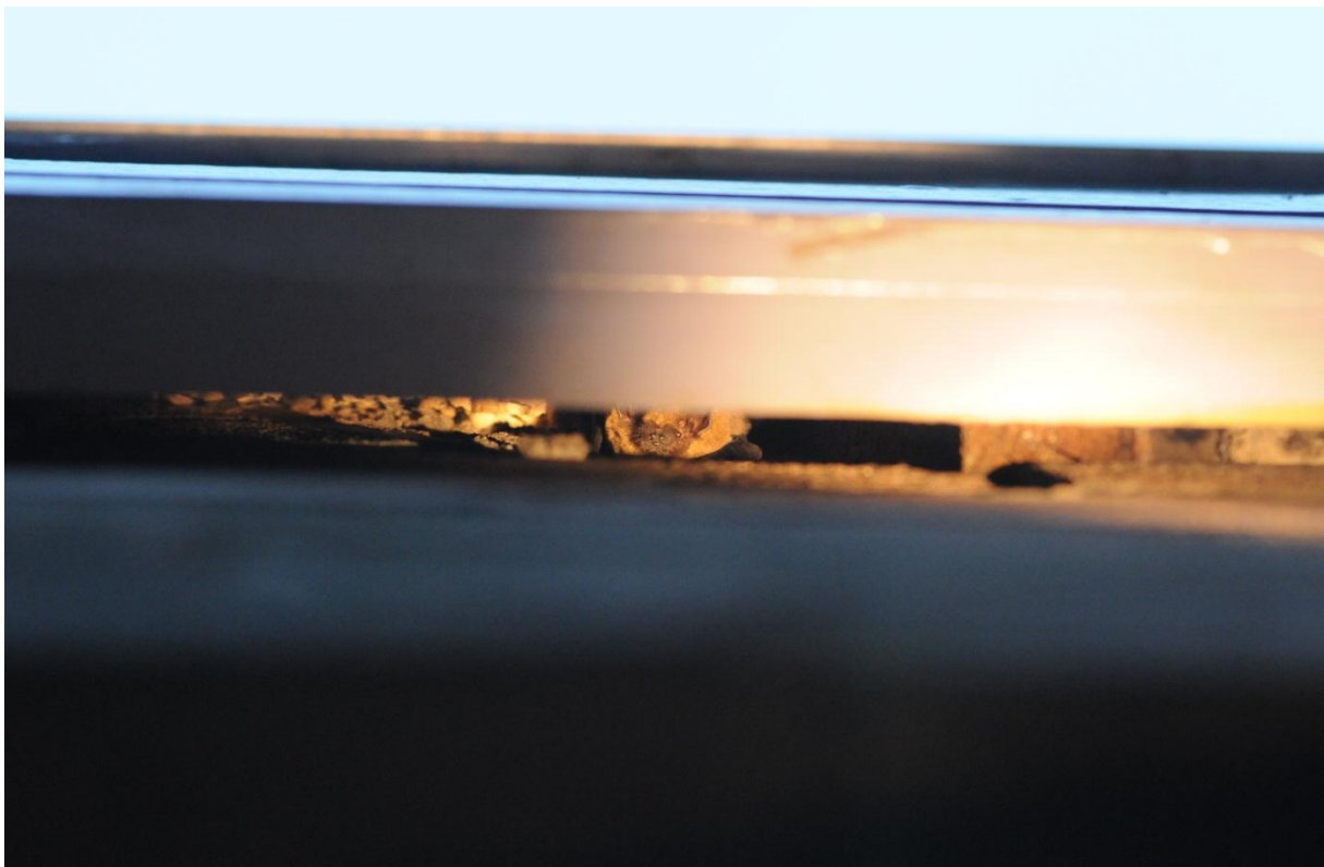
Figuur 2. Dwergvleermuis achter gevelbetimmering schoolgebouw
