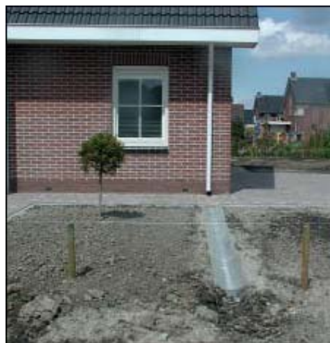
Figuur 9: gootje om hemelwater af te voeren
