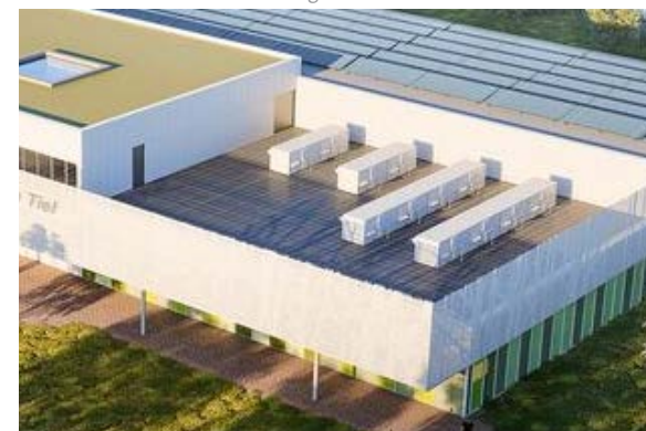
Figuur 20. Technische installaties zijn niet waarneembaar op maaiveld
