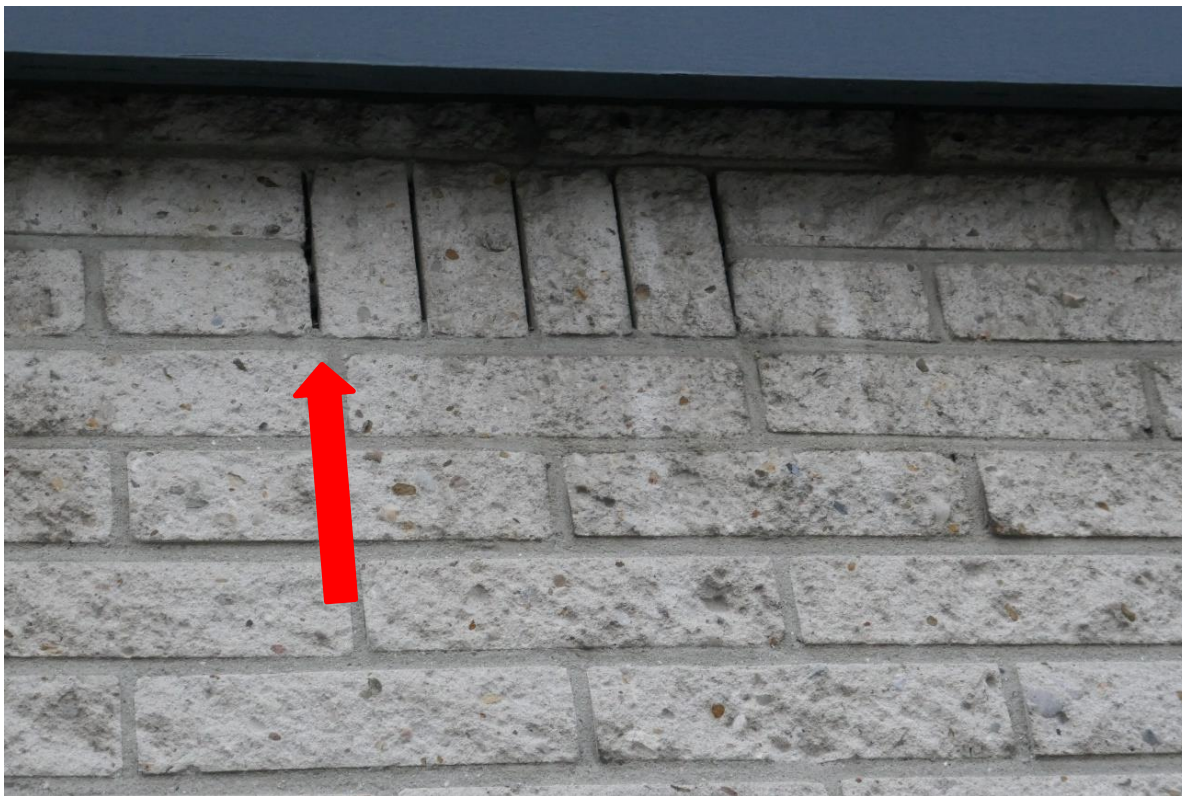
Foto 1: In het pand zijn enkele openingen aanwezig die als vaste rust- en verblijfplaats voor vleermuizen kunnen dienen
