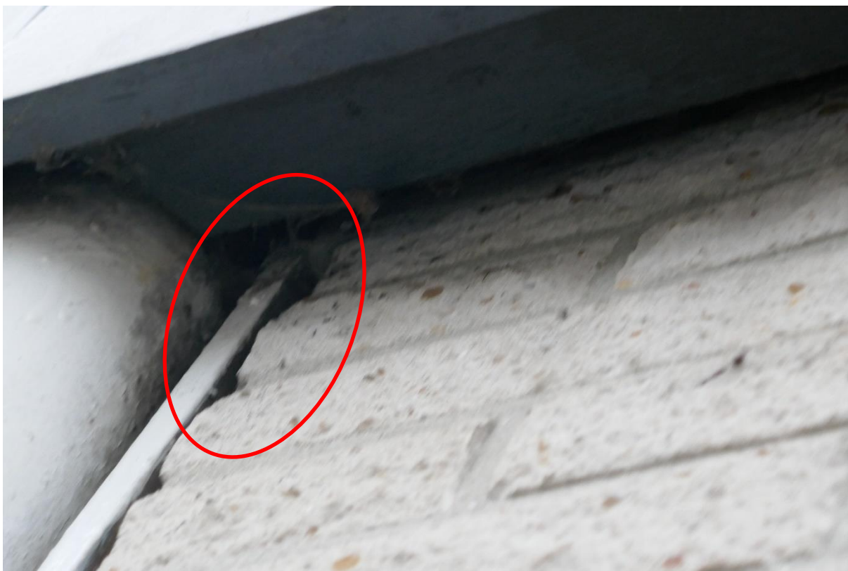
Foto 2: Dergelijke openingen vormen ook potentiële verblijfplekken voor vleermuizen
