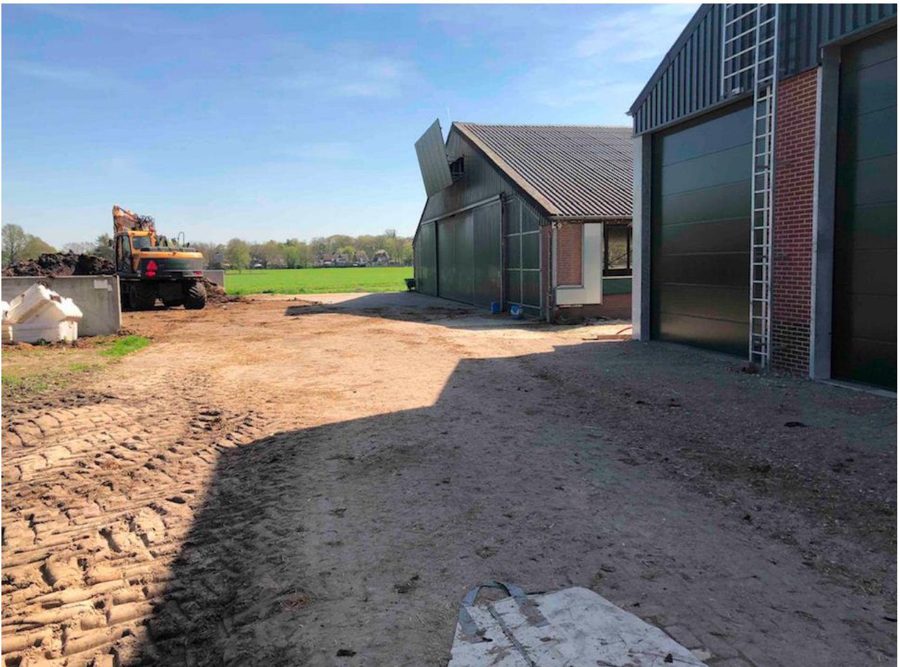
Afbeelding 1: achtermuur van de stallen waar de uitbreiding aan vast moet komen
