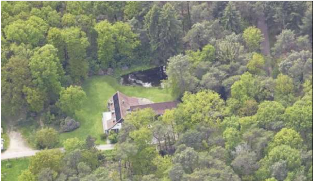
Figuur 3: Luchtfoto Stevert 13 (28 mei 2021)
