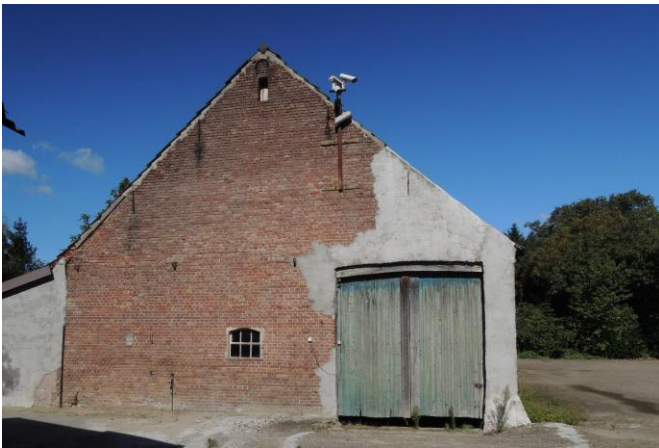
Te verwijderen bepleistering
