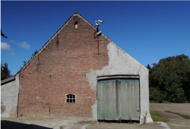
Te verwijderen bepleistering
