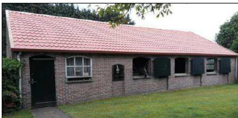
Figuur 7: Bestaande paardenstal (Bron: Bouwhistorisch Onderzoek Dick Zweers, juni 2018)
