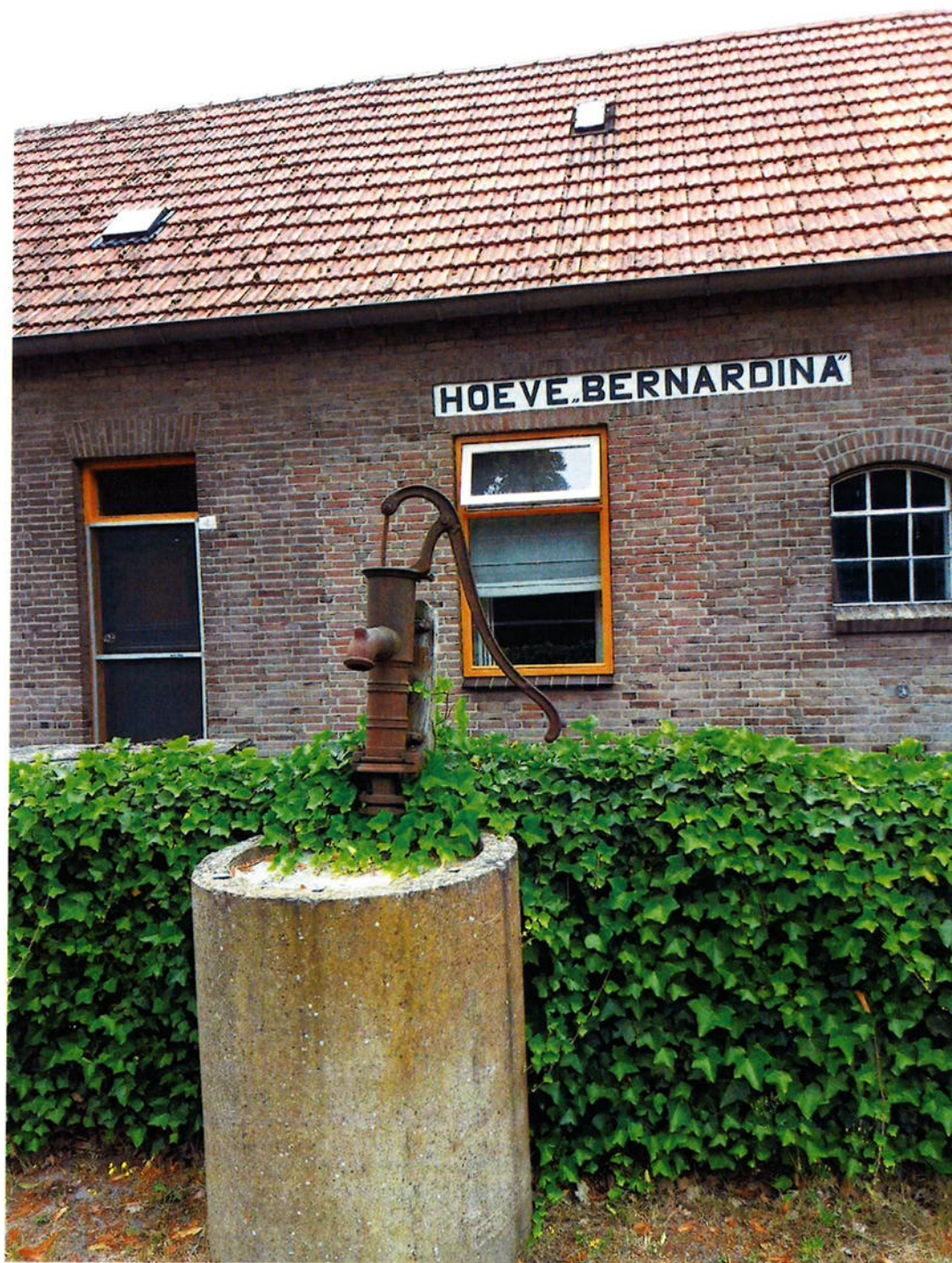
Afb. 18; zuidoostgevel met naamopschrift, bouwsporen, put en pomp.
