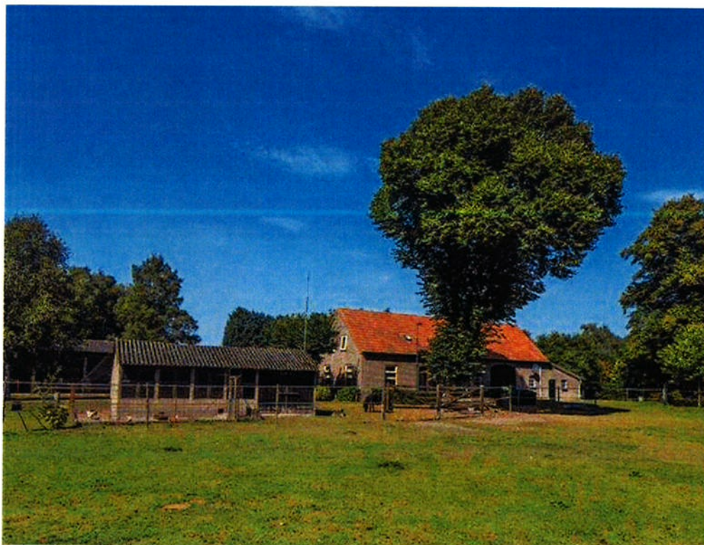
Afb. 15; ensemble vanuit het zuiden.
