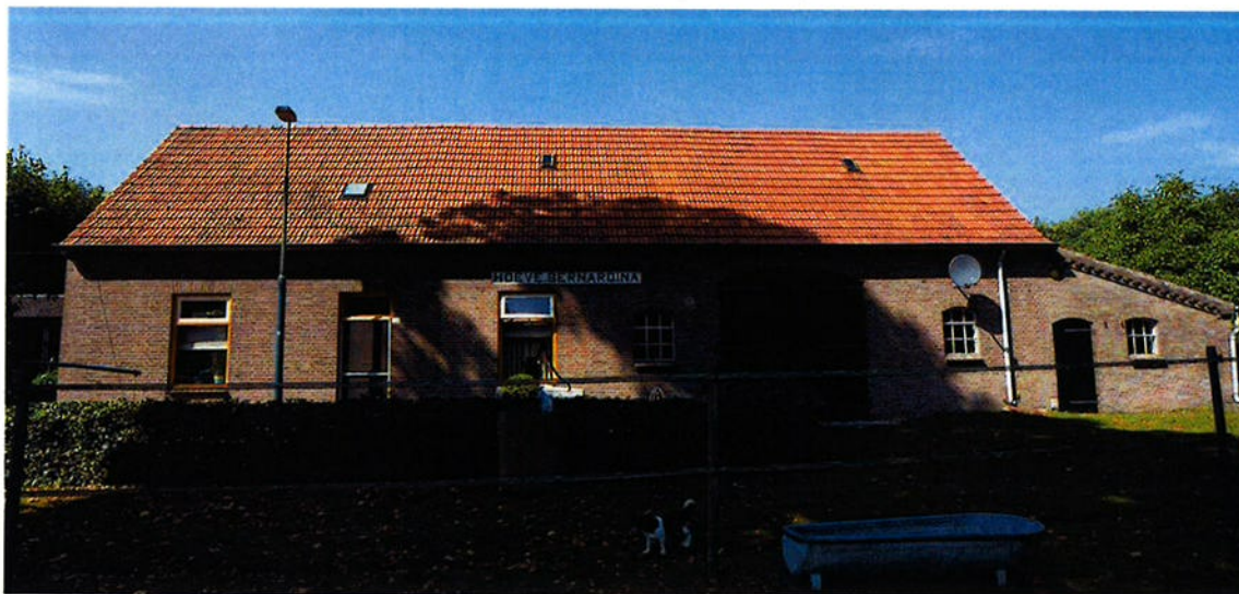
Afb. 7; de zuidgevel in 2018; rechts de aanbouw met lessenaarsdak.
