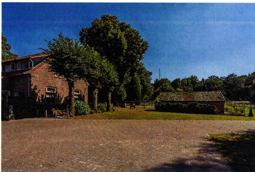
Afb. 16; west- en noordgevel, leibomen.
