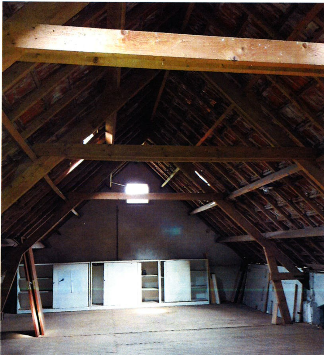
Afb. 25; zolder boven de stal naar het oosten.
