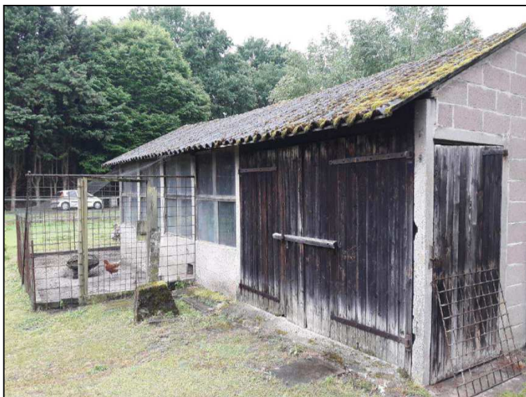
Figuur 9: Bestaand kippenhok (Bron: Bouwhistorisch Onderzoek Dick Zweers, juni 2018)
