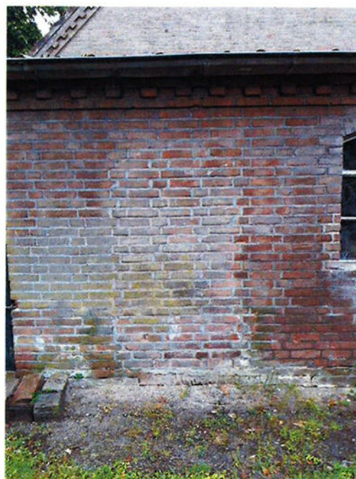
Afb. 32; details en bouwsporen oostgevel.
