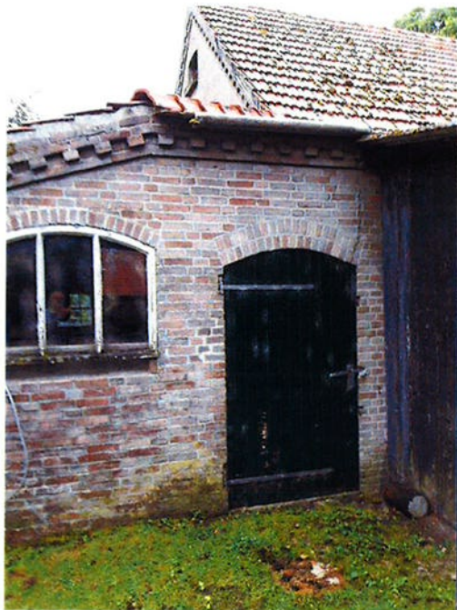
Afb. 31; het oostelijke eind van de noordgevel.
