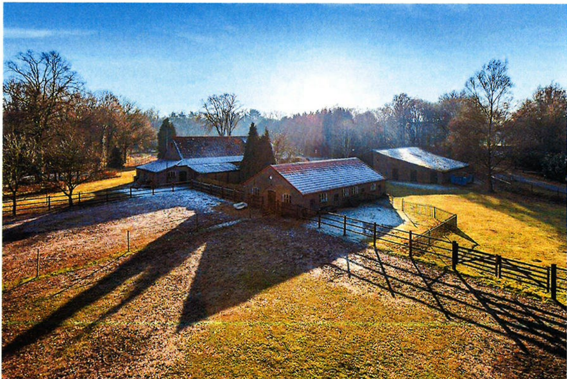
Afb. 37; erf en opstallen vanuit het noorden.
