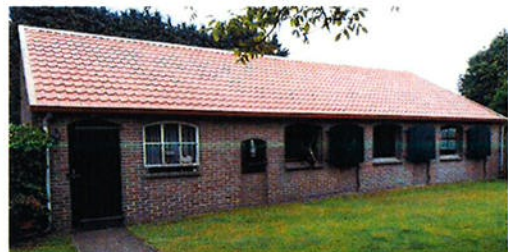
Afb. 34; bijgebouw 5.1 vanuit het zuiden.
