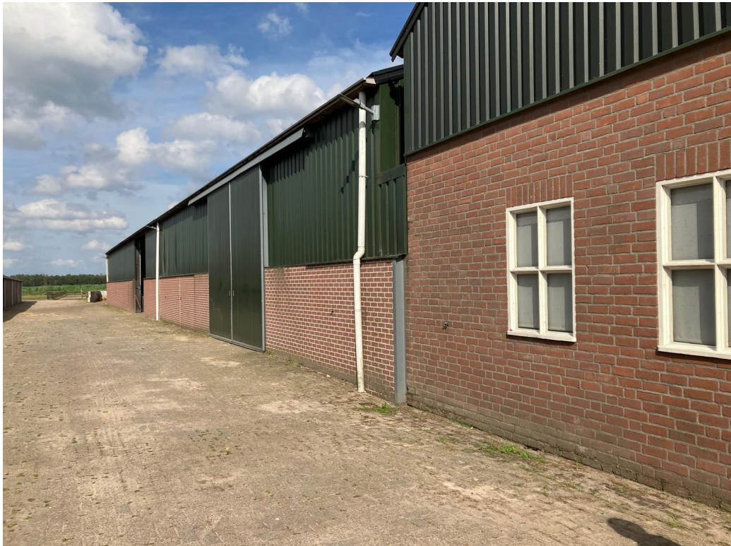
• Afbeelding 5: Bedrijfsgebouwen, linker deel wordt gesloopt, rechter deel blijft behouden
