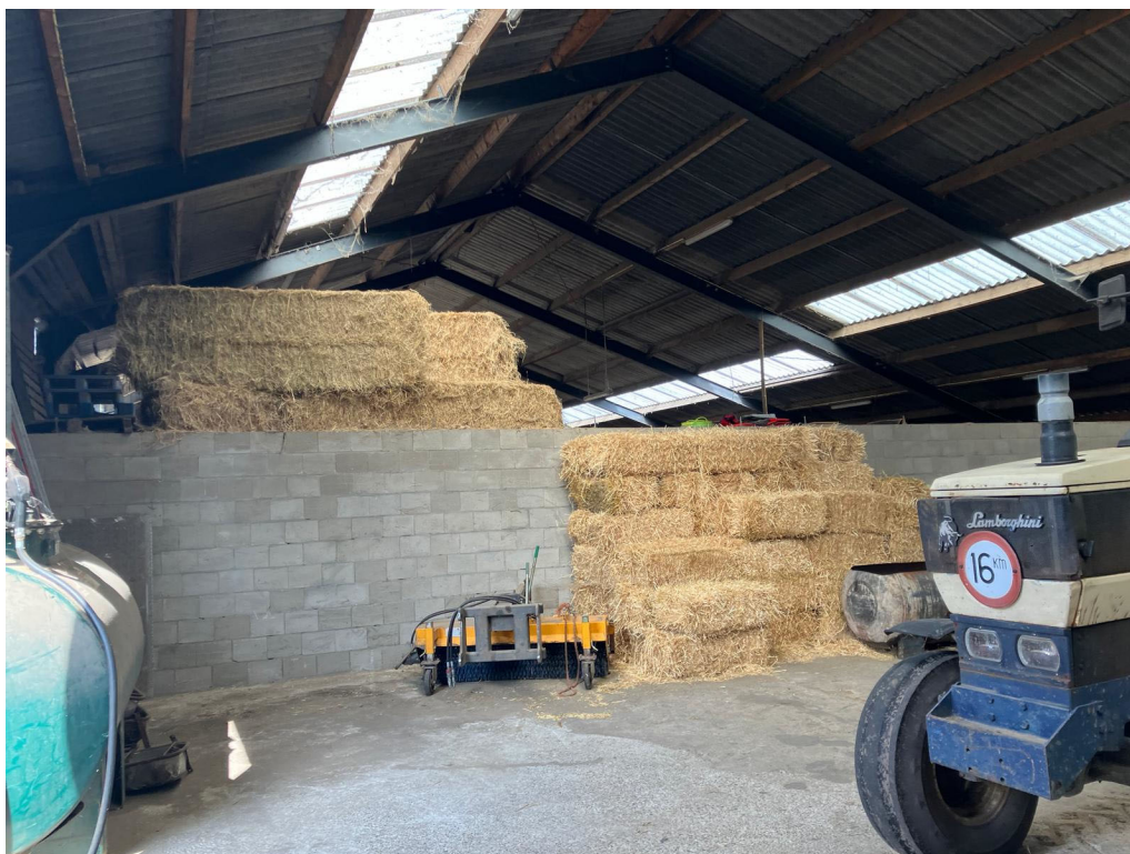
• Afbeelding 9: Binnenzijde bedrijfsgebouw, wordt gesloopt
