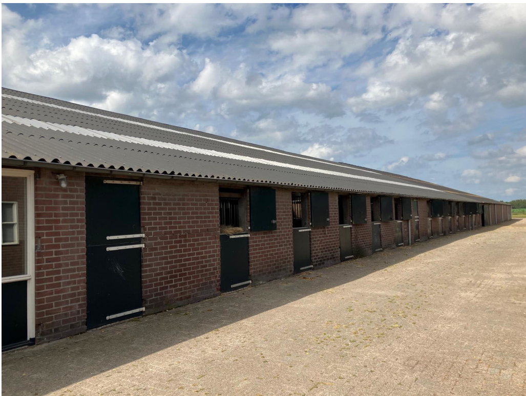
• Afbeelding 18: Zijgevel te slopen bedrijfsgebouw
