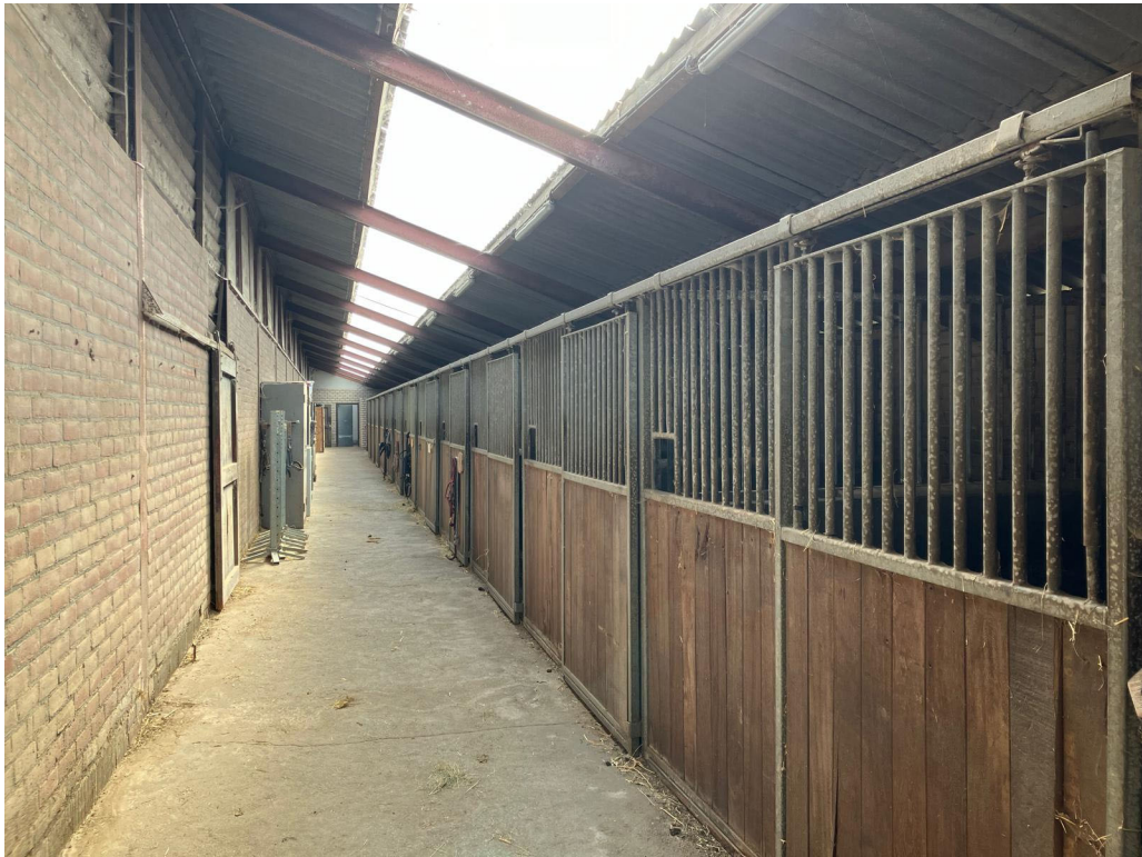
• Afbeelding 15: Binnenzijde bedrijfsgebouw
