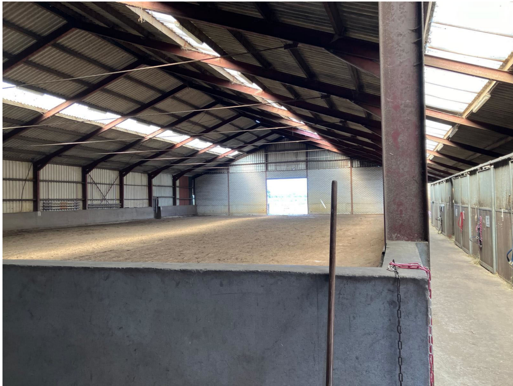
• Afbeelding 7: Binnenzijde te slopen bedrijfsgebouw
