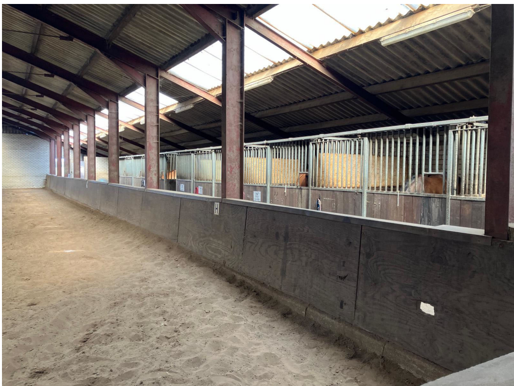
• Afbeelding 6: Binnenzijde te slopen bedrijfsgebouw
