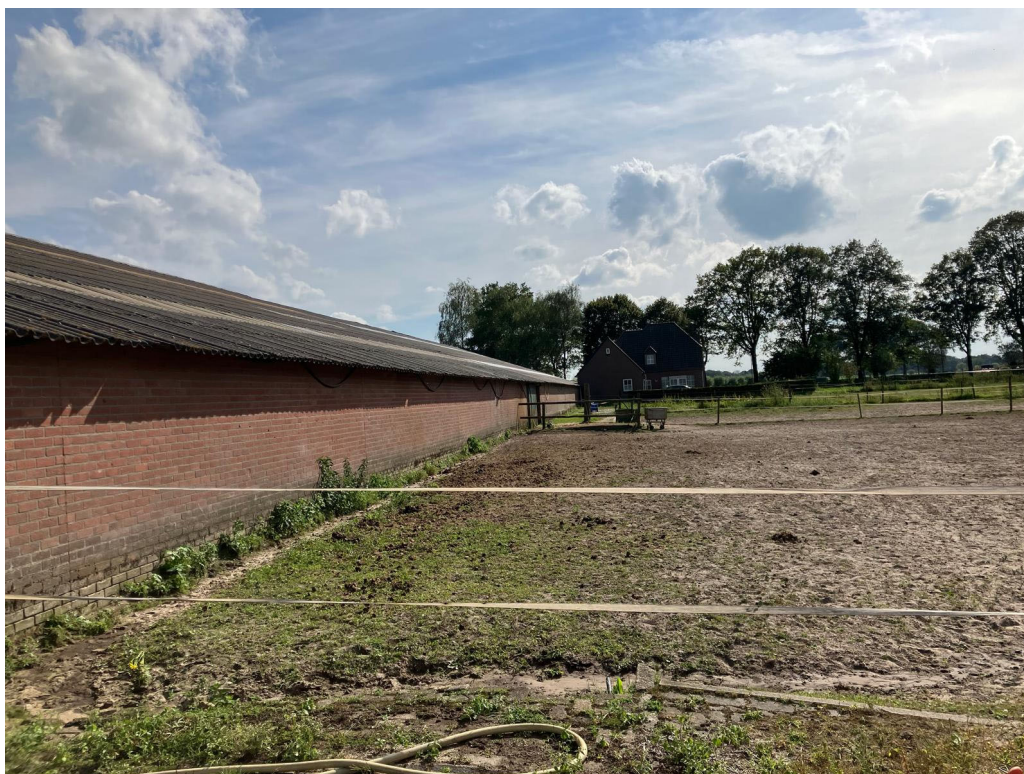
• Afbeelding 21: Zijgevel te slopen bedrijfsgebouw
