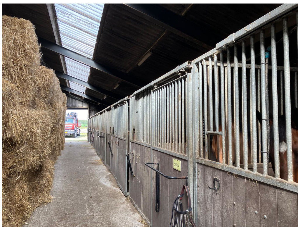
• Afbeelding 10: Binnenzijde bedrijfsgebouw, wordt gesloopt
