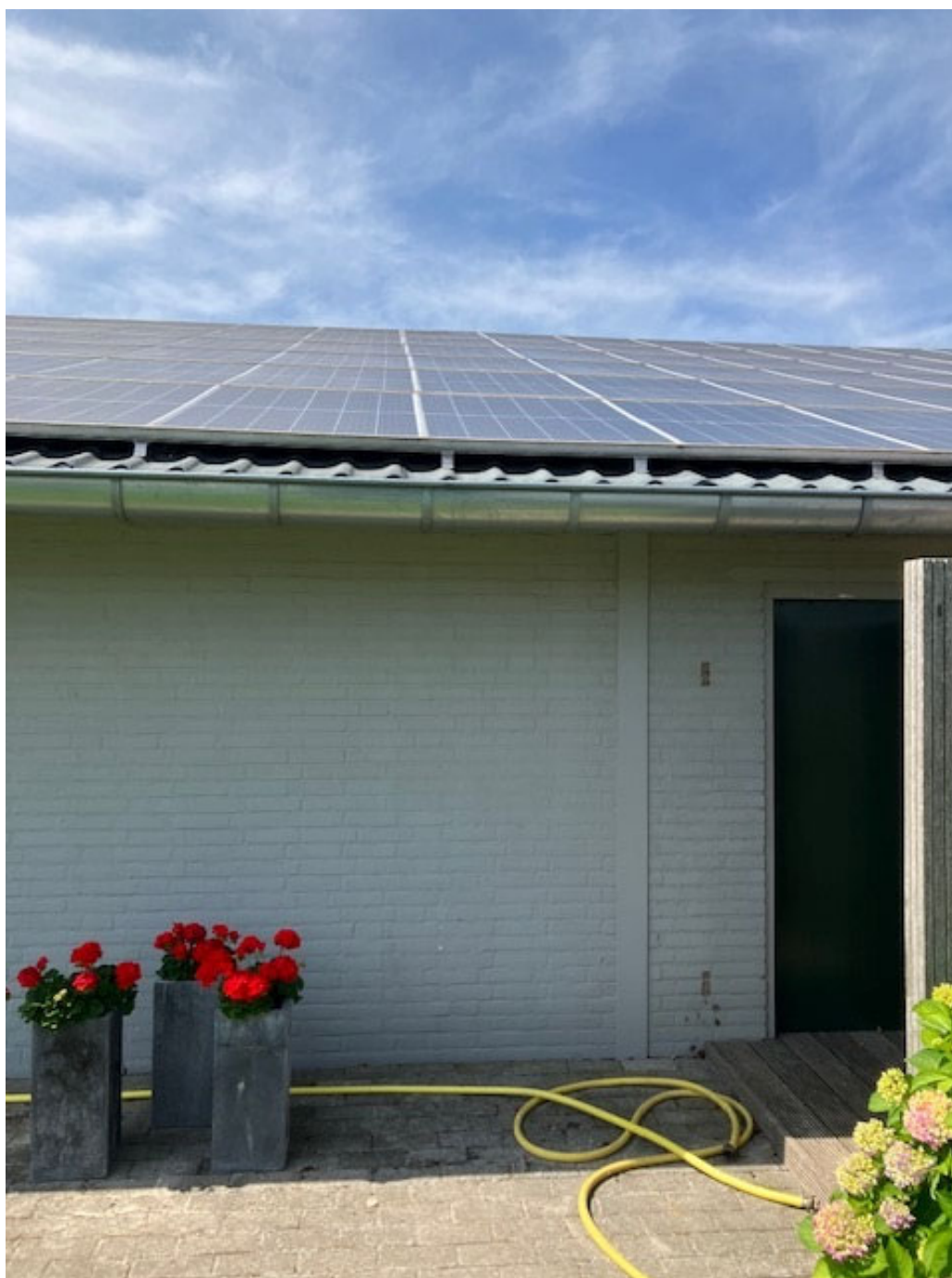
• Afbeelding 18: Links blijft staan en rechts gaat gesloopt worden
