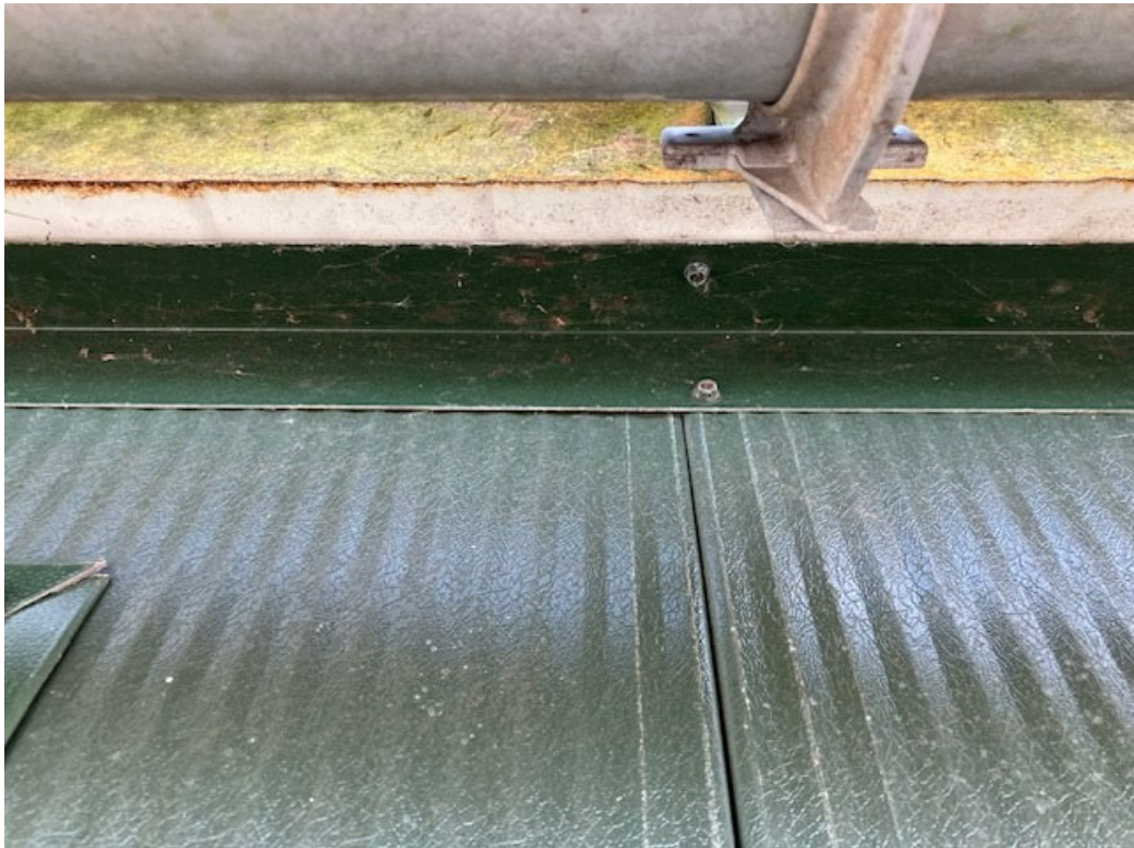
Afbeelding 12: dakaansluiting sandwichpanelen dak van voormalige stal
