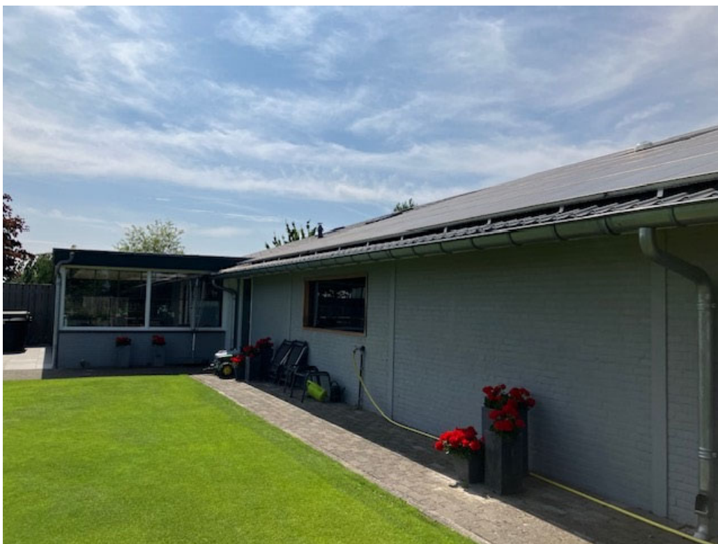
• Afbeelding 19: Het woonhuis met een stukje van de schuur blijft behouden
