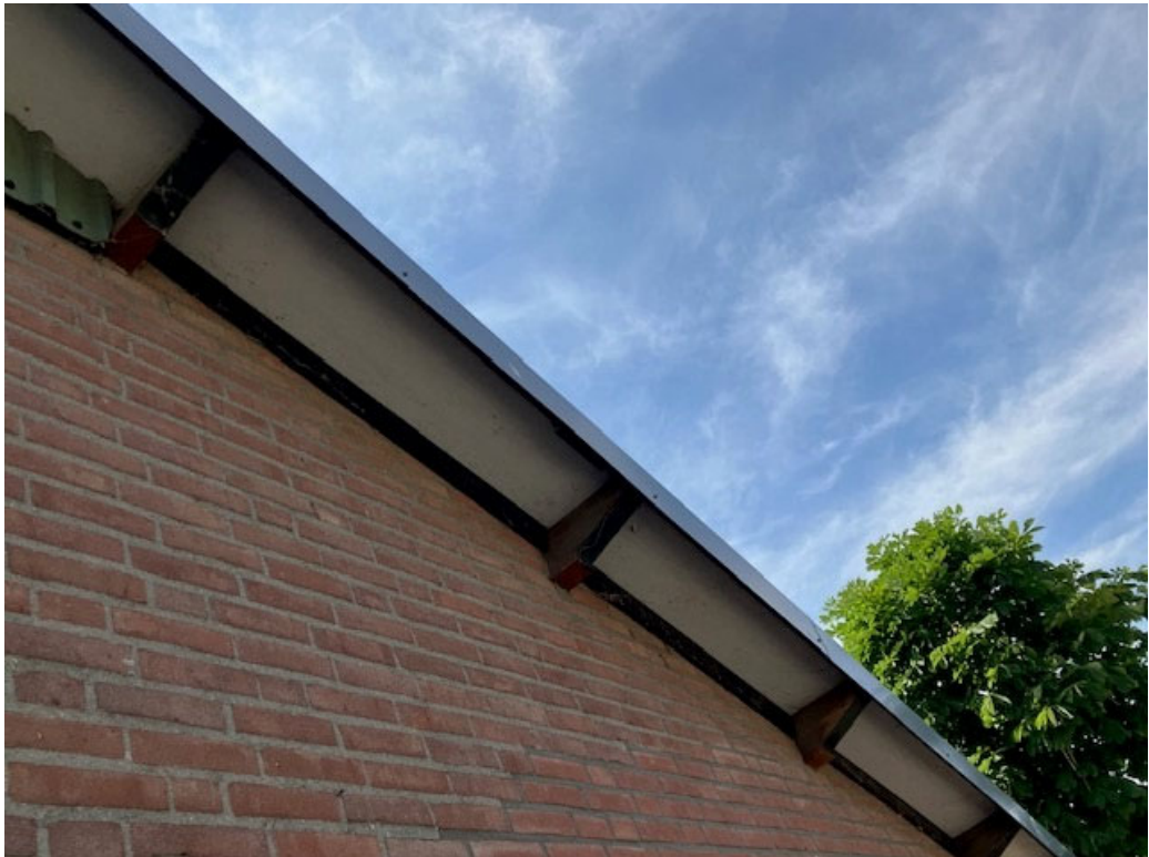
• Afbeelding 7: Dak aansluiting geheel dicht
