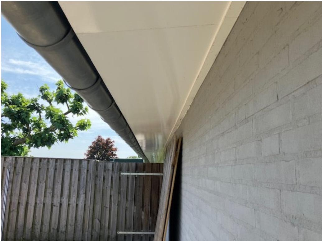
• Afbeelding 10: Dakaansluiting is geheel dicht
