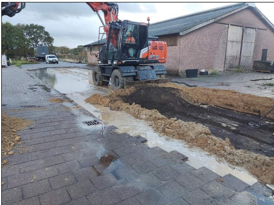
Figuur 4. Aanleg van werkput 3.
