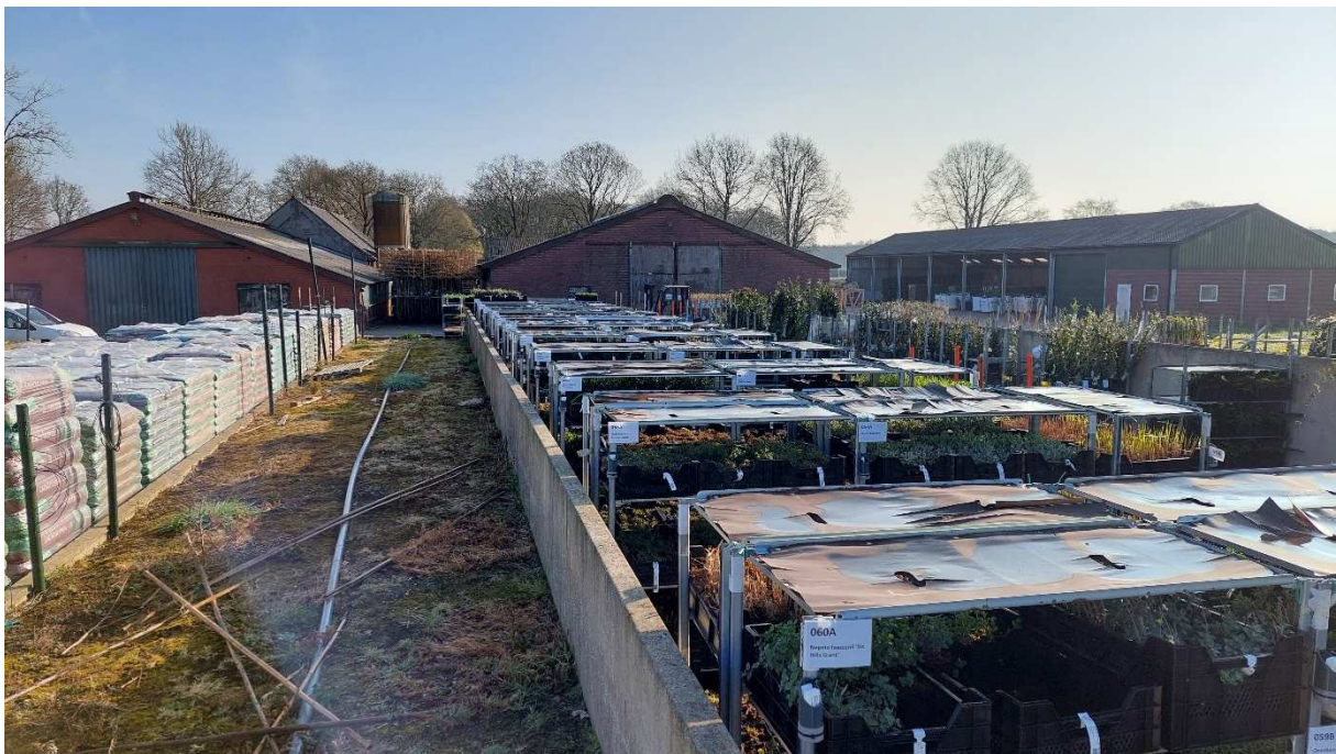
Figuur 24: Foto vanaf het achtererf met de mestplaten en sleufsilo's richting het historisch erf met aan de linkerkant de stal uit 1979 achter de historische boerderij, in het midden de stal uit 1988 en rechts de werktuigenloods uit 2005. Gefotografeerd richting het noordoosten (bron: KSP Archeologie).
