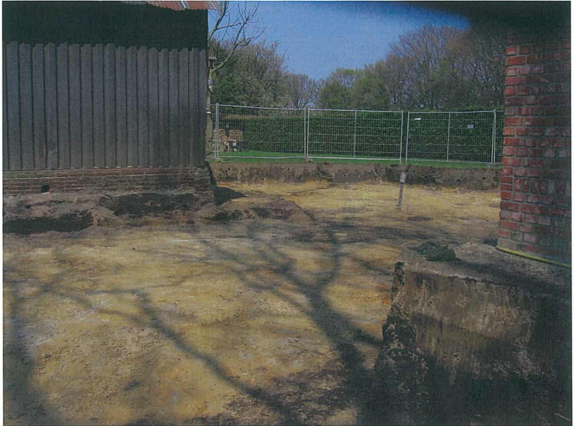
Foto 3: ontgraving ter plaatse van 5p2.
