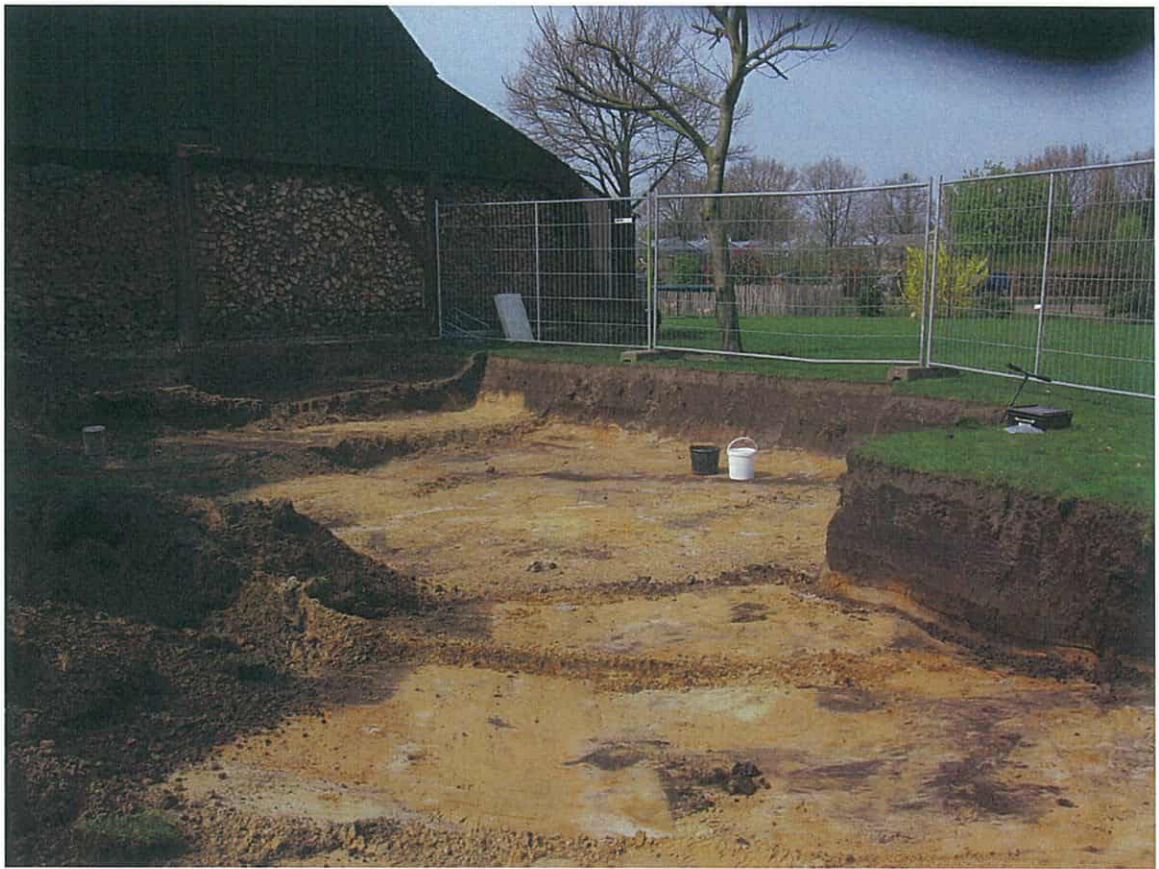
Foto 1: uitgevoerde ontgraving ter plaatse van putbodemp 3p1 en 5p2.
