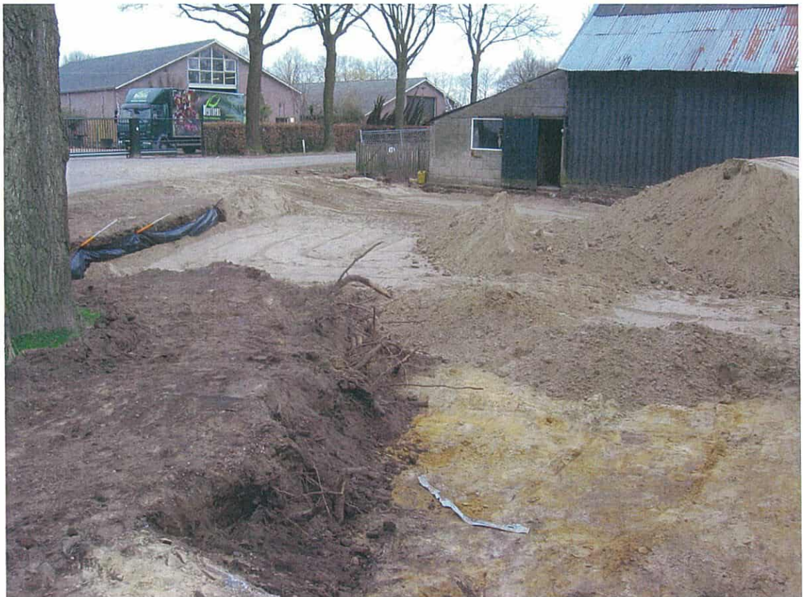
foto 4: Tijdens het aanvullen van de ontgraving.
